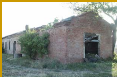
edificio principale (ed. 3)
