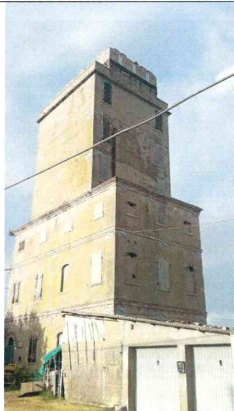
Foto 5 – Torre senza copertura
