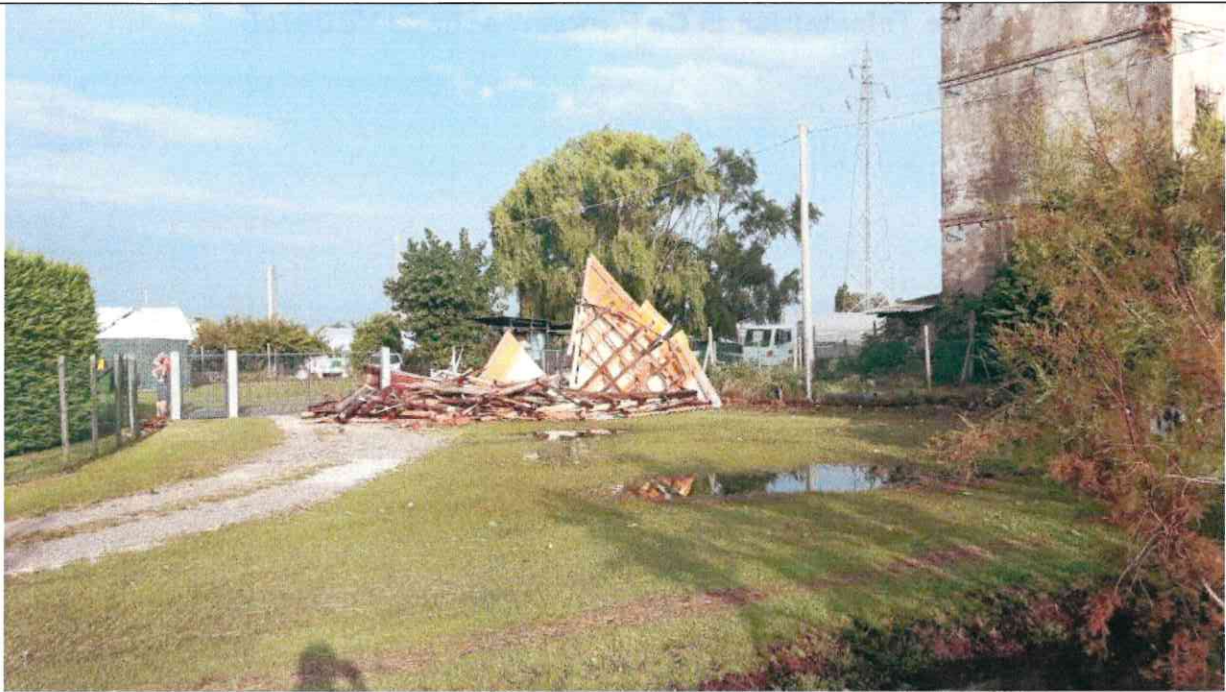
Foto 3 – copertura spazzata via dal vento
