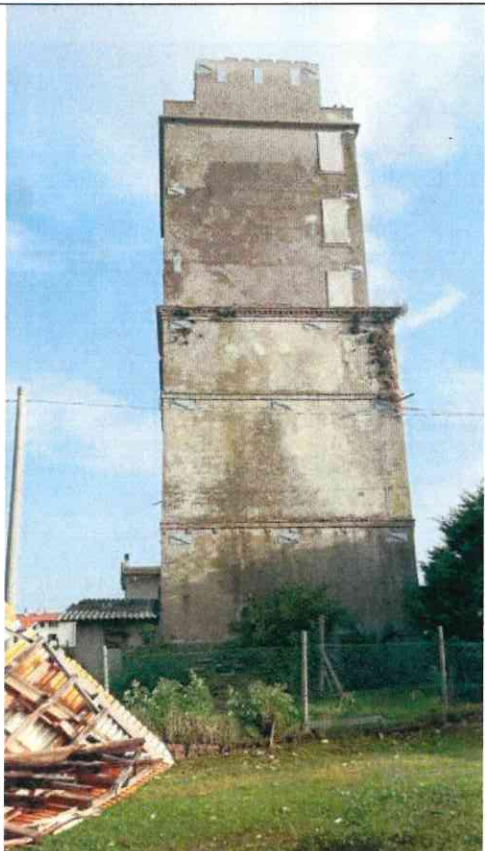
Foto 4 – Torre senza copertura
