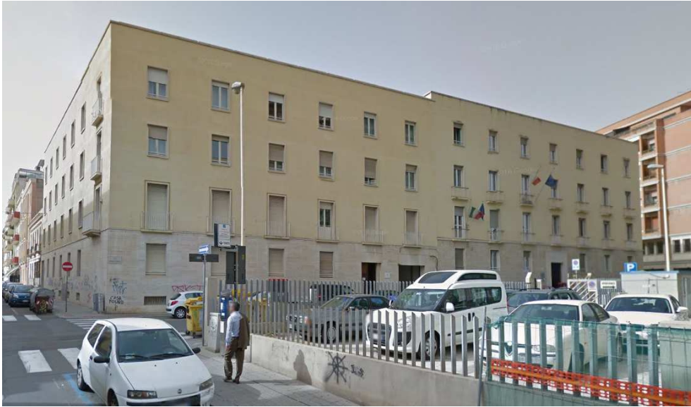
Fig. 1 - Sede dell'Agencia del demanio sita in Cagliari, Via lo Frasso n. 2
