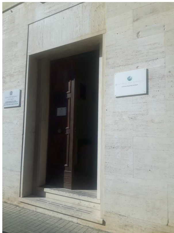
Fig. 2 - Sede dell'Agencia del demanio sita in Cagliari, Via lo Frasso n. 2
