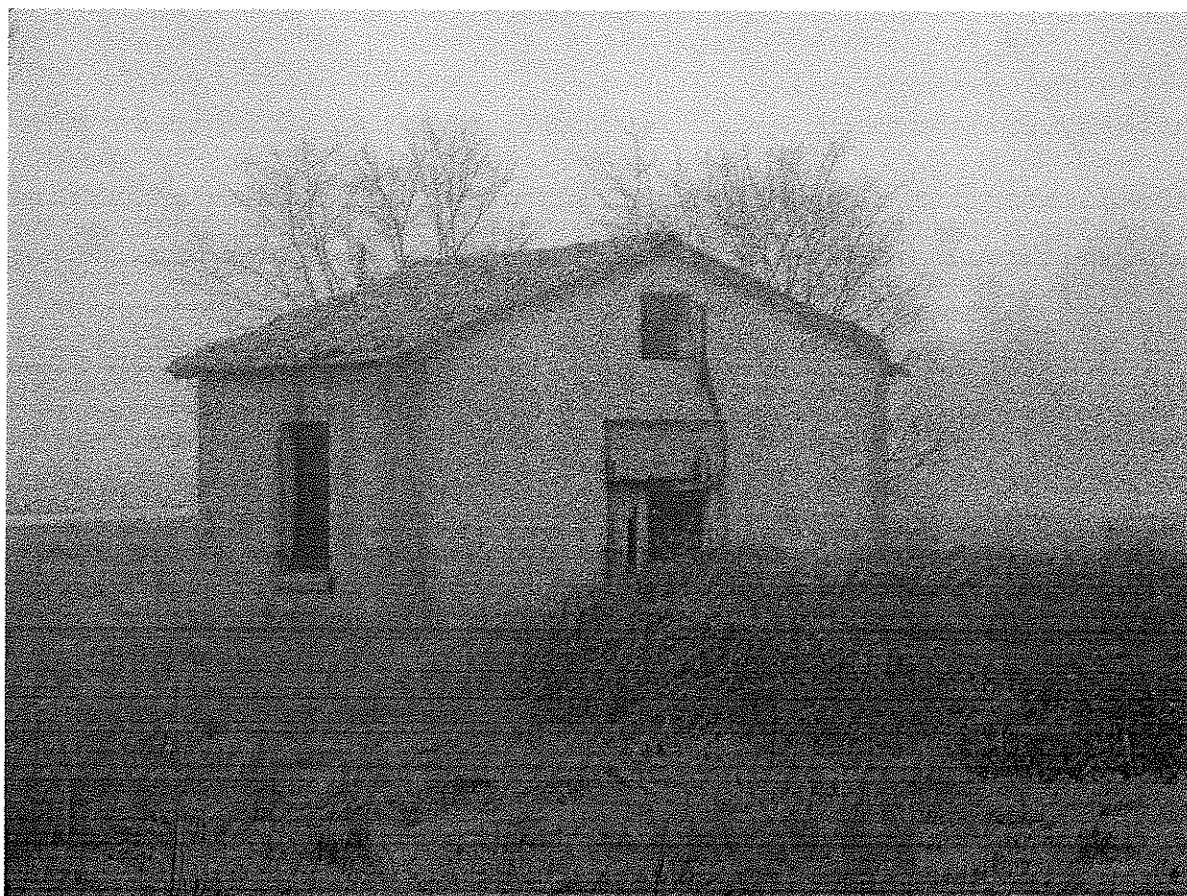
Foto 06 vista fabbricato secondario dove occorre rimuovere i rifiuti di vario genere presenti e chiudere le aperture con rete elettrosaldata e tubi innocenti e rete arancione plastificata
