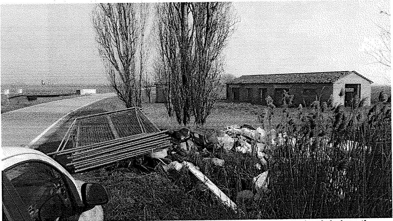
Foto 01 vista accesso al compendio con abbandono di rifiuti scaricati da ignoti. Il punto di installazione della barra manuale è in corrispondenza dei pannelli di recinzione oggi rimossi.
