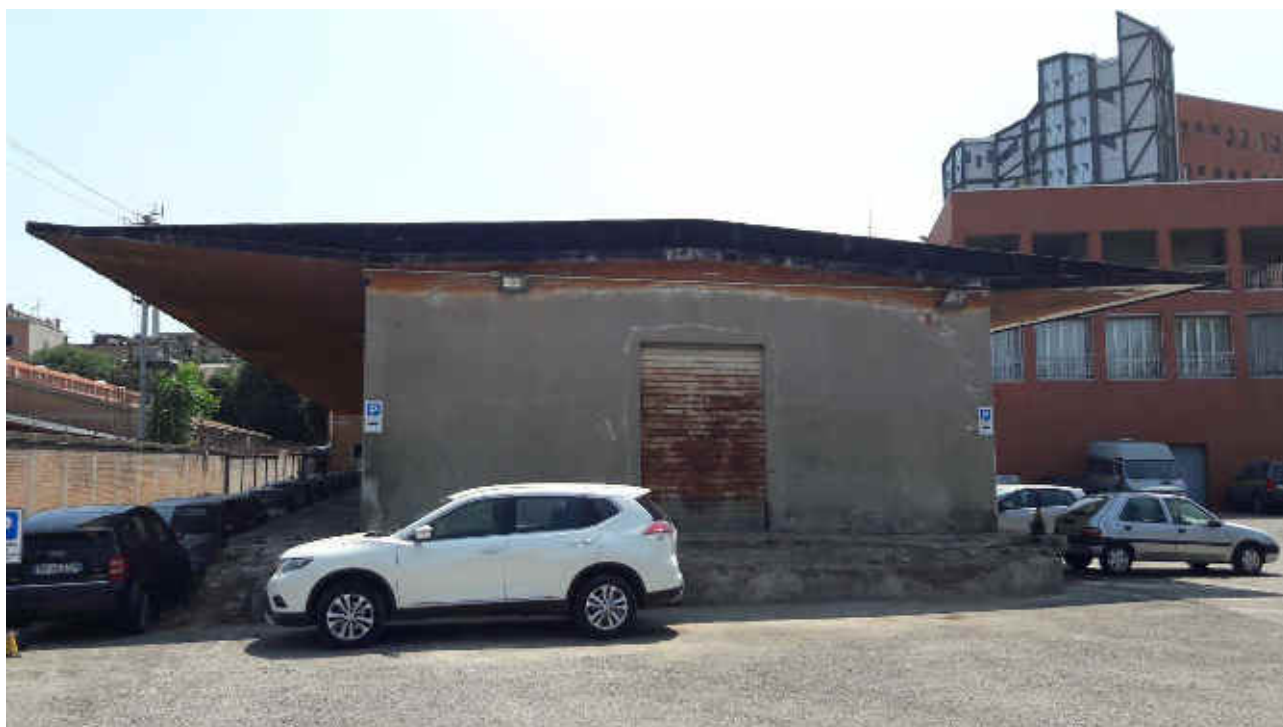
Corpo Magazzino Prospetto Ovest
