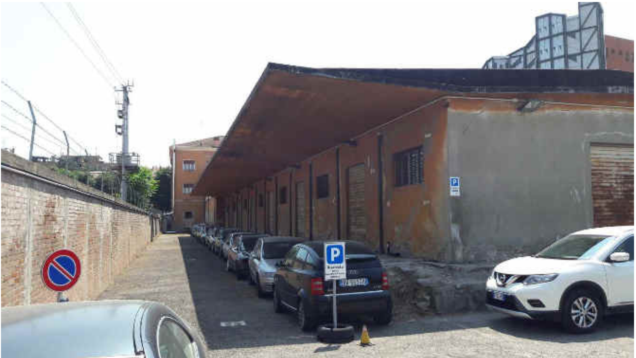
Corpo magazzino Prospetto Nord
