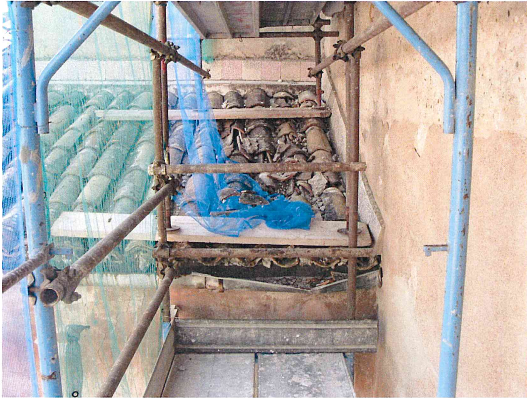
Copertura angolo sud-est cortile Palazzo Marchesi
