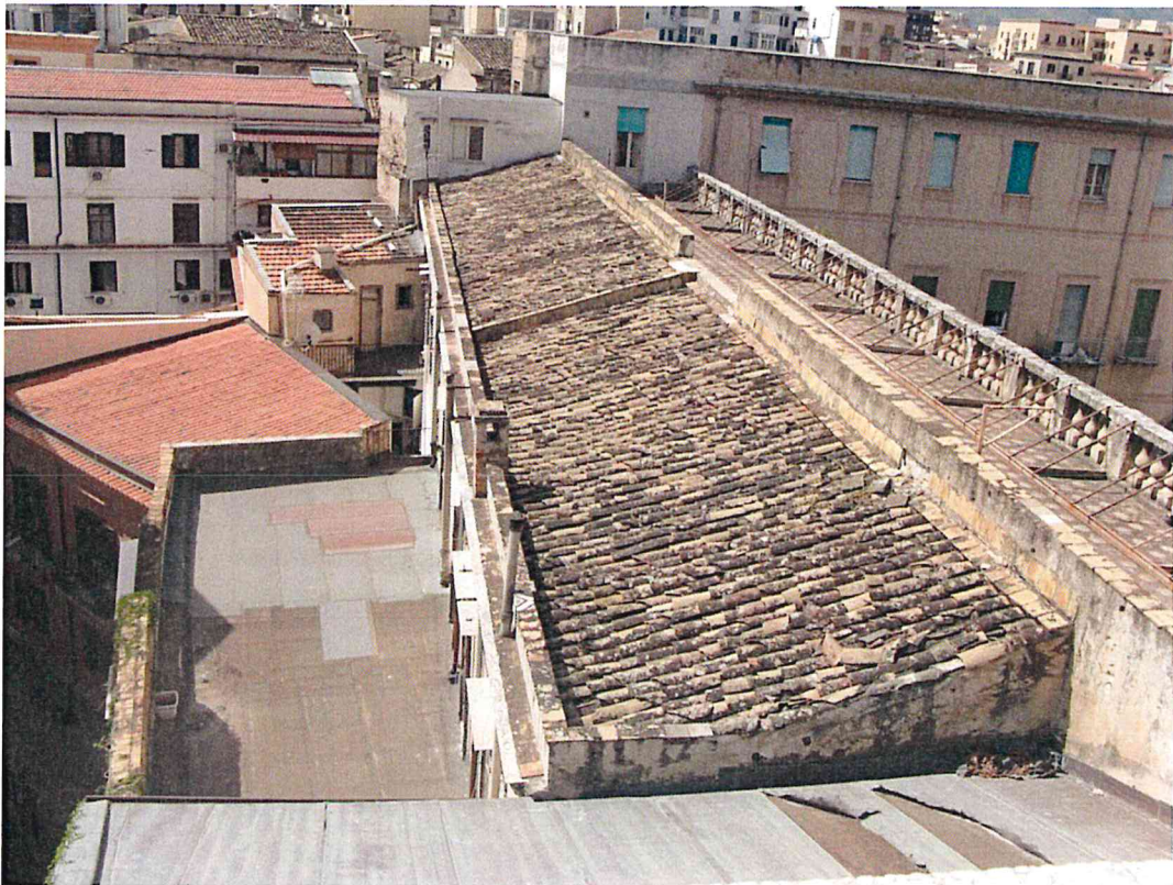
Sostituzione/integrazione dei coppi e controllo della struttura lato est cortile quadrato Controllo e integrazione guaina terrazza
