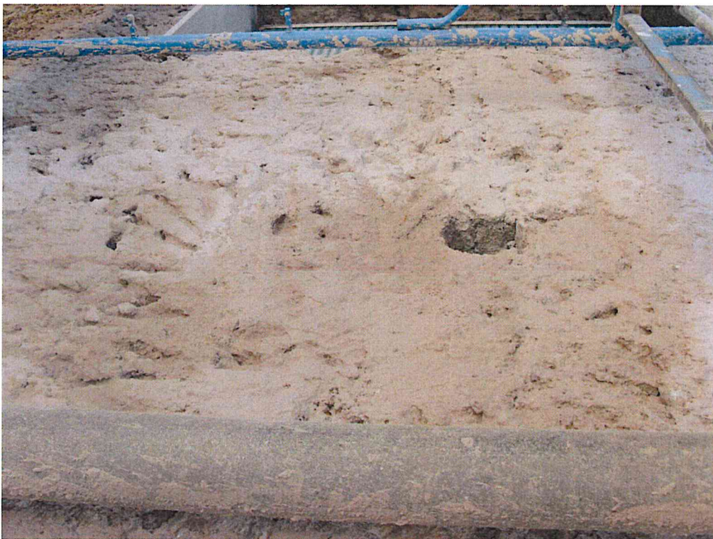
Prospetto dopo l'applicazione del rinzaffo
