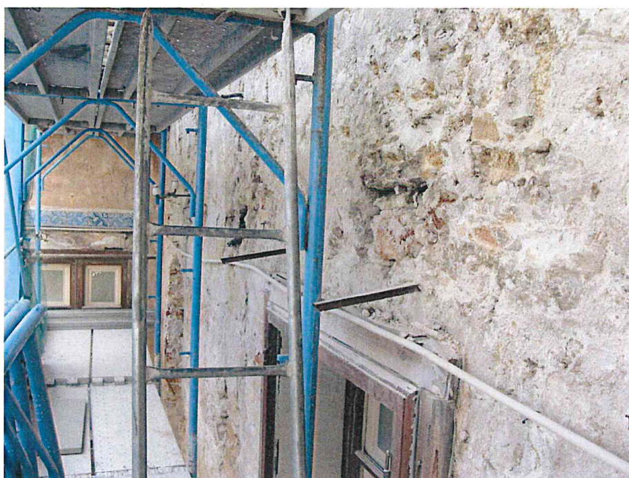
Prospetto dopo la picchettatura dell'intonaco
