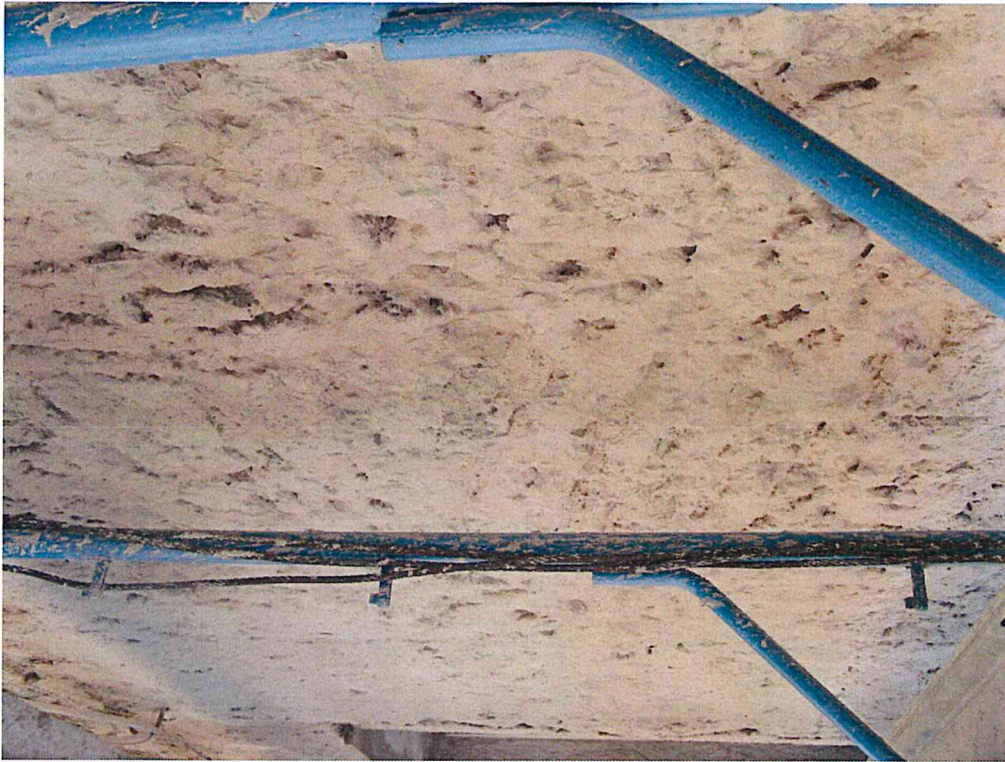
Prospetto dopo l'applicazione del rinzaffo
