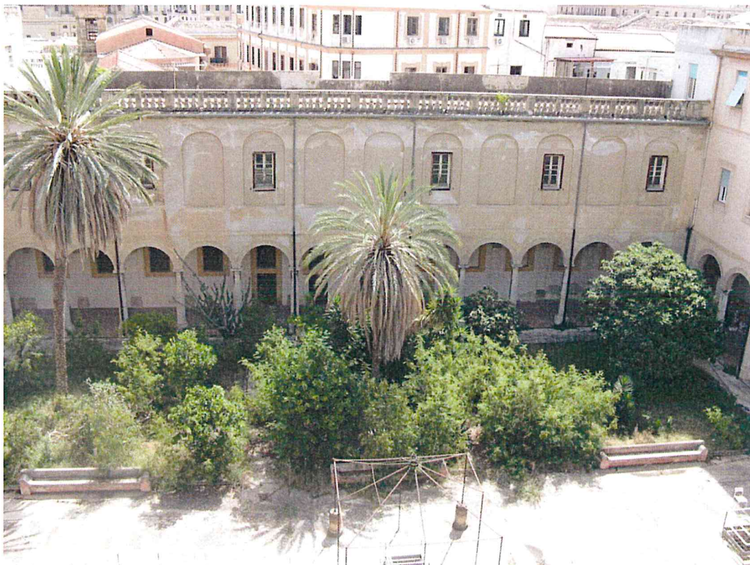
Prospetto est cortile quadrato da controllare previo nuovo sopralluogo congiunto
