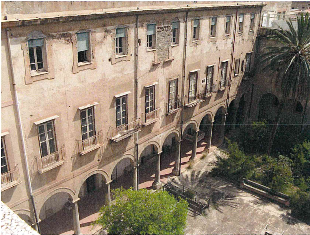
Prospetto nord cortile quadrato da controllare previo nuovo sopralluogo congiunto
