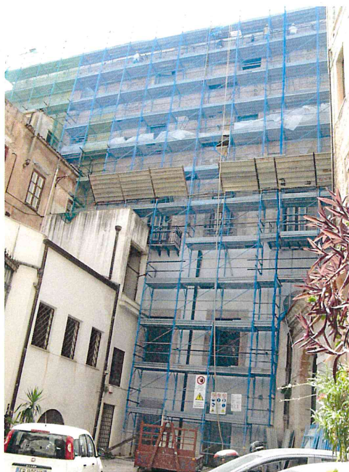
Ponteggio prospetto sud cortile Palazzo Marchesi
