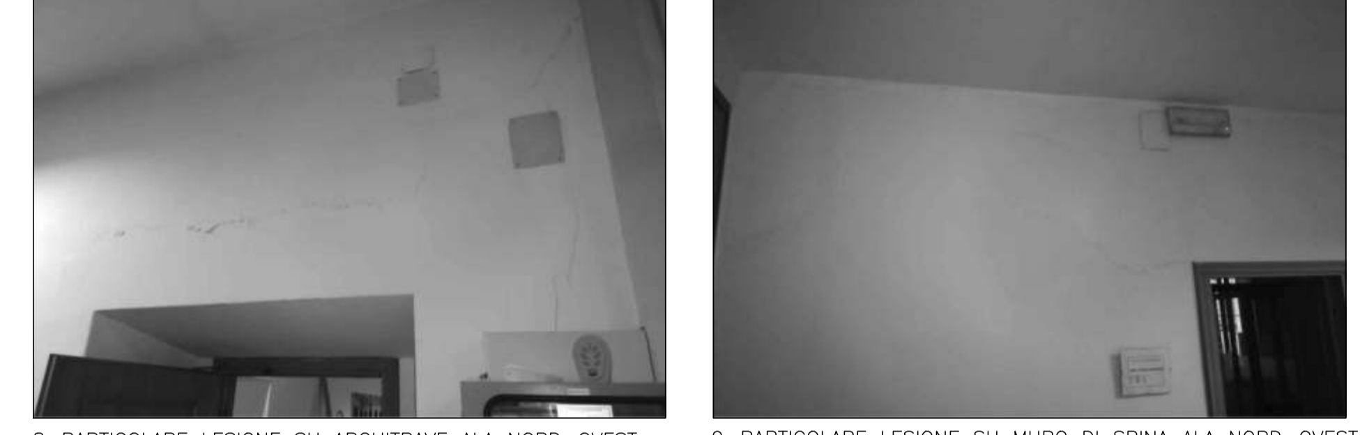
8-PARTICOLARE LESIONE SU ARCHITRAVE ALA NORD-OVEST 9-PARTICOLARE LESIONE SU MURO DI SPINA ALA NORD-OVEST
