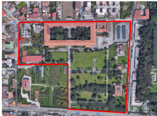
INTERVENTI DA EFFETTUARE SU IMMOBILE CED0064
