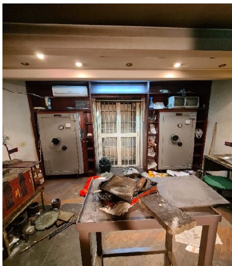
INTERVENTO DA EFFETTUARE SU IMMOBILE NAB1243
