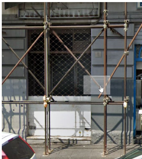
INTERVENTO DA EFFETTUARE SU IMMOBILE NAB0982
