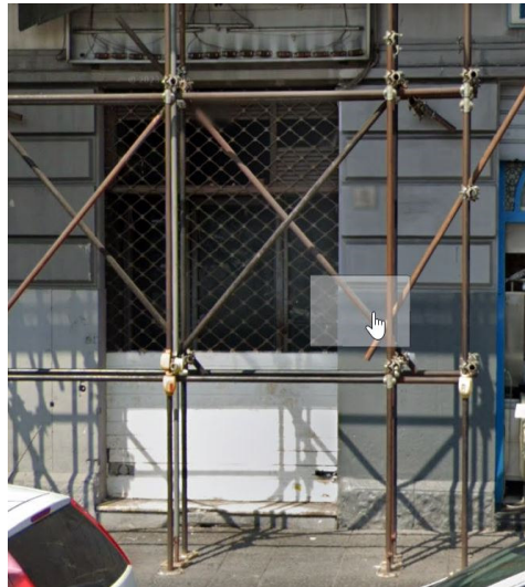
INTERVENTO DA EFFETTUARE SU IMMOBILE NAB0982
