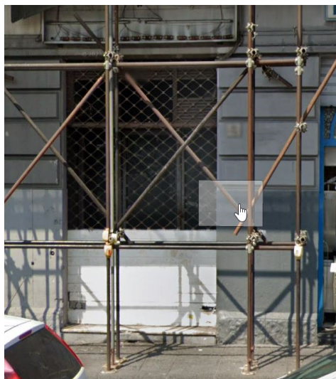
INTERVENTO DA EFFETTUARE SU IMMOBILE NAB0982
