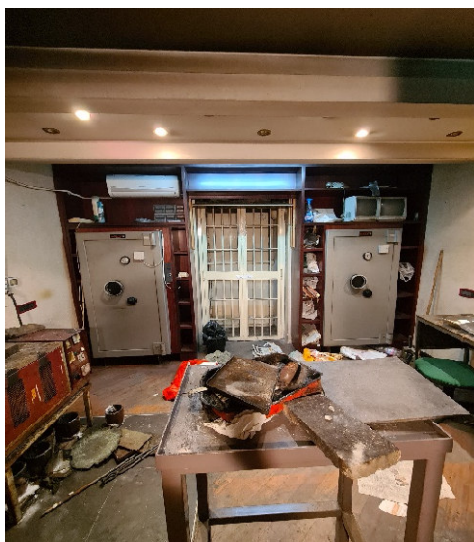
INTERVENTO DA EFFETTUARE SU IMMOBILE NAB1243
