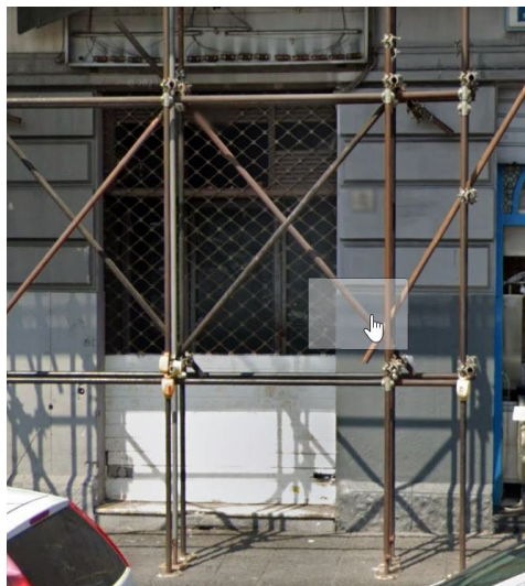
INTERVENTO DA EFFETTUARE SU IMMOBILE NAB0982
