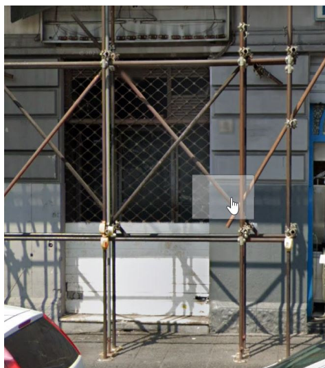
INTERVENTO DA EFFETTUARE SU IMMOBILE NAB0982
