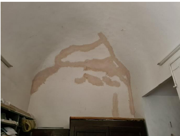
Foto 11 – vista interna piano primo
