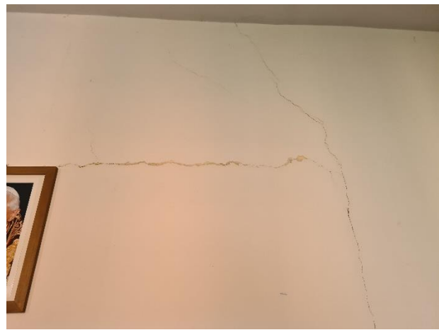
Foto 4 – vista interna piano primo
