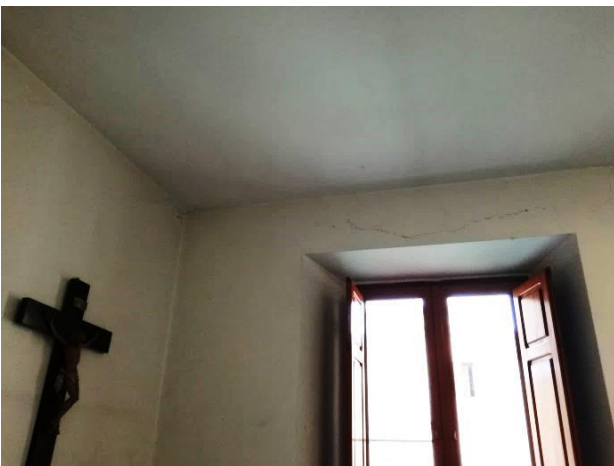
Foto 3 – vista interna piano primo
