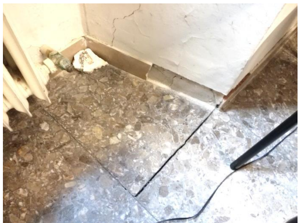
Foto 8 – vista interna piano primo
