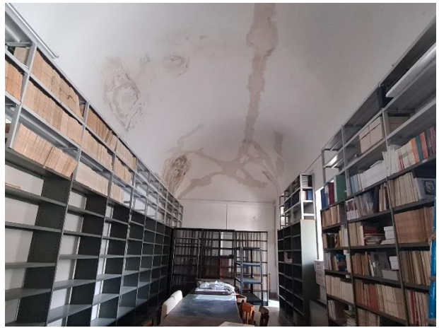
Foto 10 – vista interna piano primo
