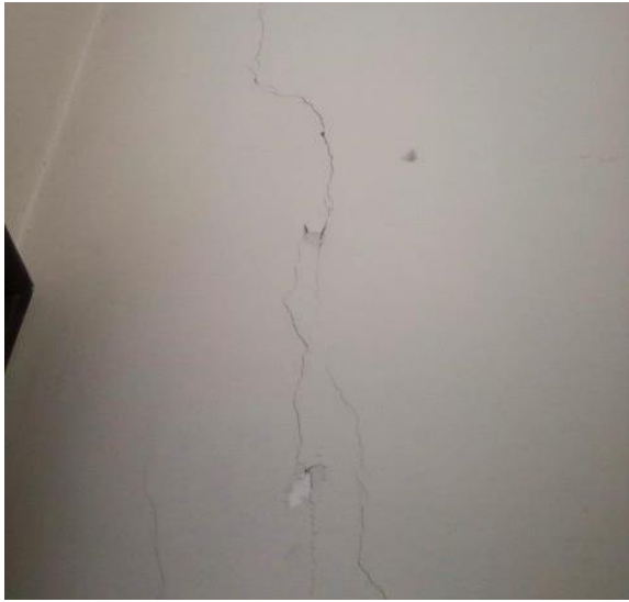
Foto 15 – vista interna piano primo
