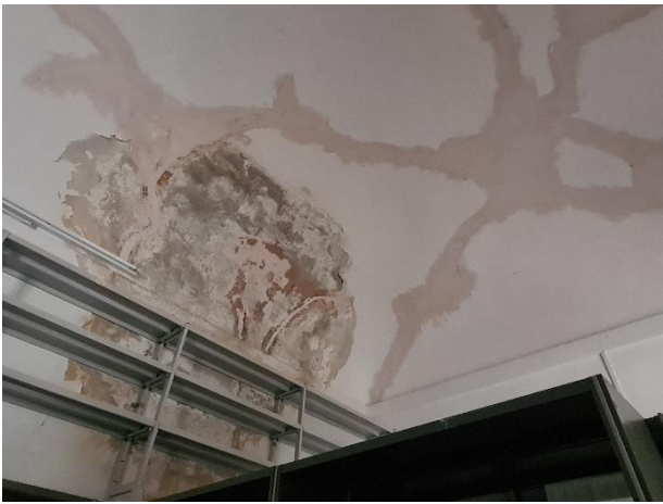
Foto 9 – vista interna piano primo
