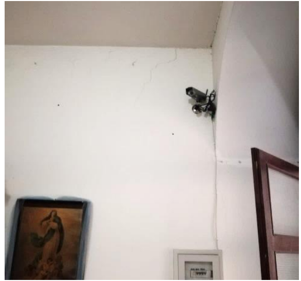
Foto 16 – vista interna piano primo
