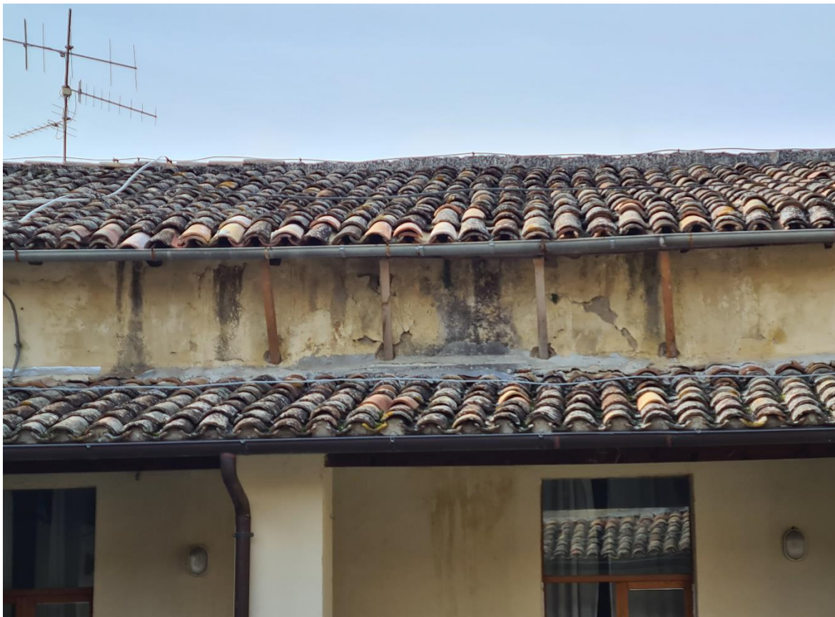
Foto 23 – copertura lato chiostro interno
