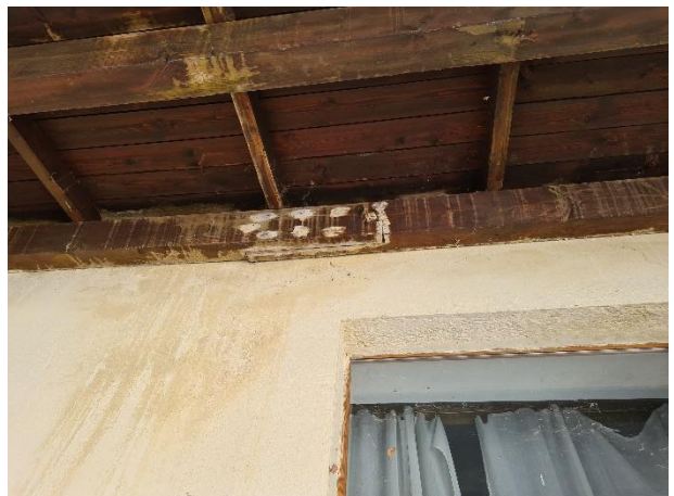
Foto 12 – vista copertura dal chiostro piano primo
