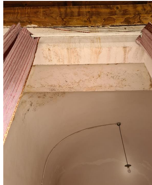
Foto 22 – vista interna piano primo
