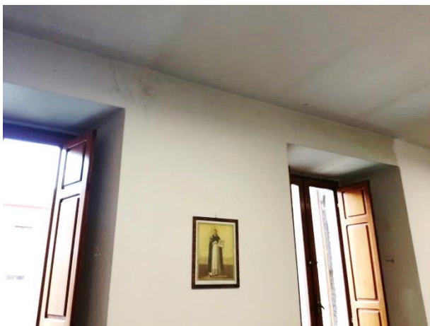
Foto 17 – vista interna piano primo
