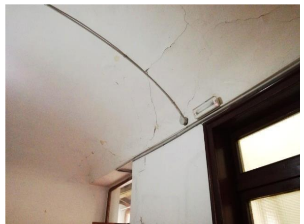
Foto 20 – vista interna piano primo
