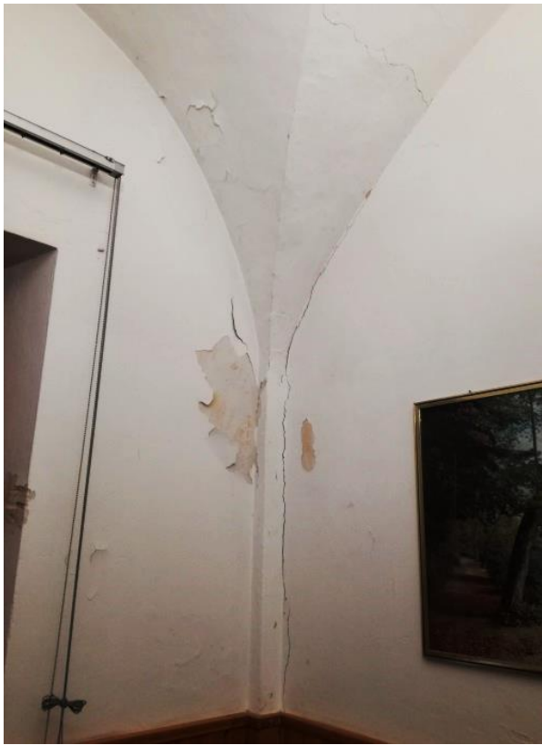
Foto 5 – vista interna piano primo
