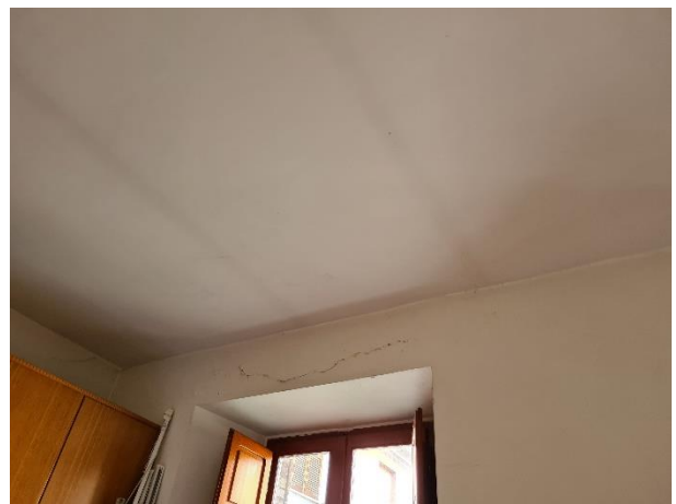
Foto 18 – vista interna piano primo
