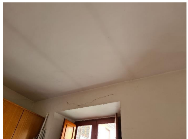
Foto 14 – vista interna piano primo
