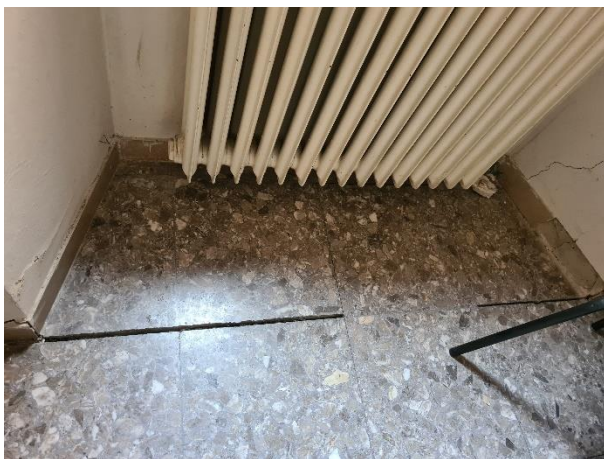
Foto 7 – vista interna piano primo
