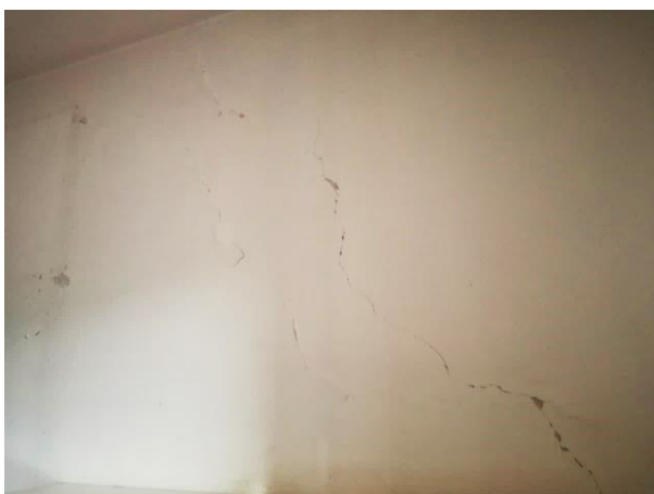
Foto 19 – vista interna piano primo
