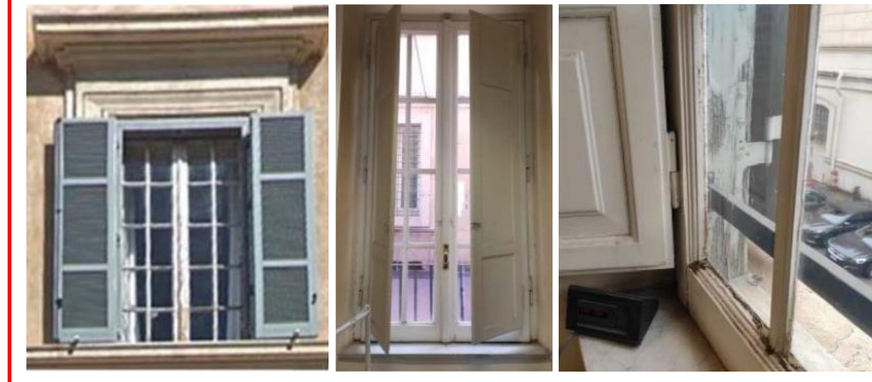
Prospetto A e B. Piano nobile caratterizzato dagli scuri interni. La sostituzione degli infissi prevede la riproposizione della stessa tipologia di infisso per tale piano. Persiane esterne e scuri interni.
