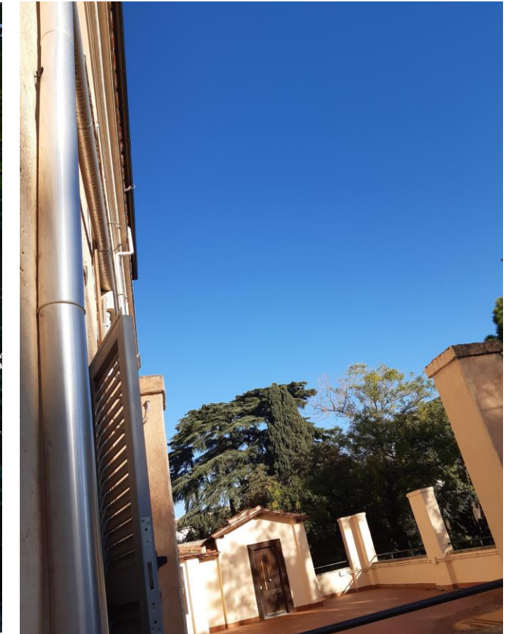
VISTA G. Terrazzo prospetto laterale ala Sud Est.
