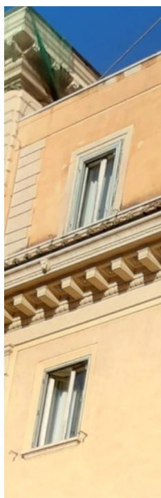
Persiane da sostituire o da ripristinare in seguito alla messa in sicurezza avvenuta negli anni per il rischio di caduta dall'alto del materiale.
