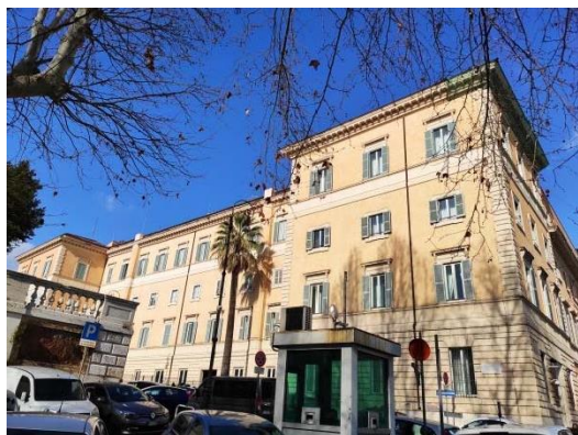
Vista del Prospetto su Via Ferrara
