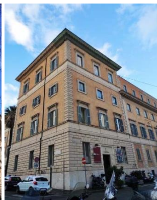
Vista del Torrione angolo Via Ferrara, Via Piacenza
