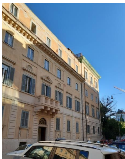
Vista del Prospetto su Via Piacenza, Palazzetto alla Sud Est
