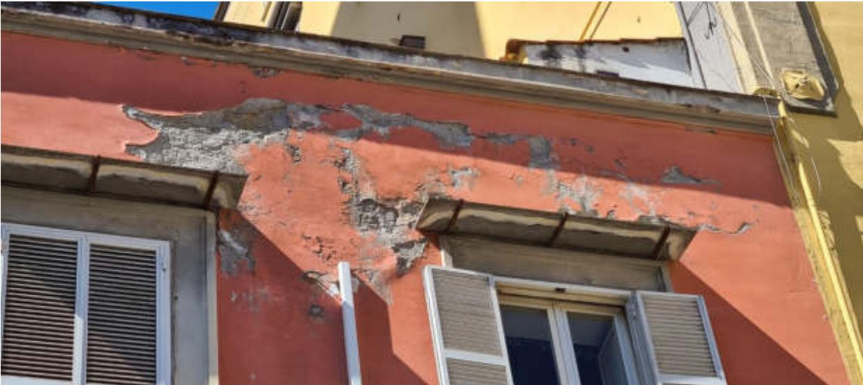
Foto: dettaglio del degrado dell'intonaco in facciata (lato dx)
