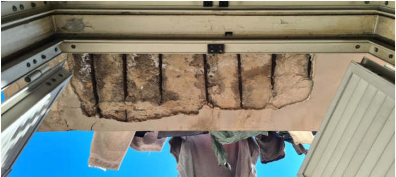
Foto – Ulteriore dettaglio del degrado dell'intradosso balconi
