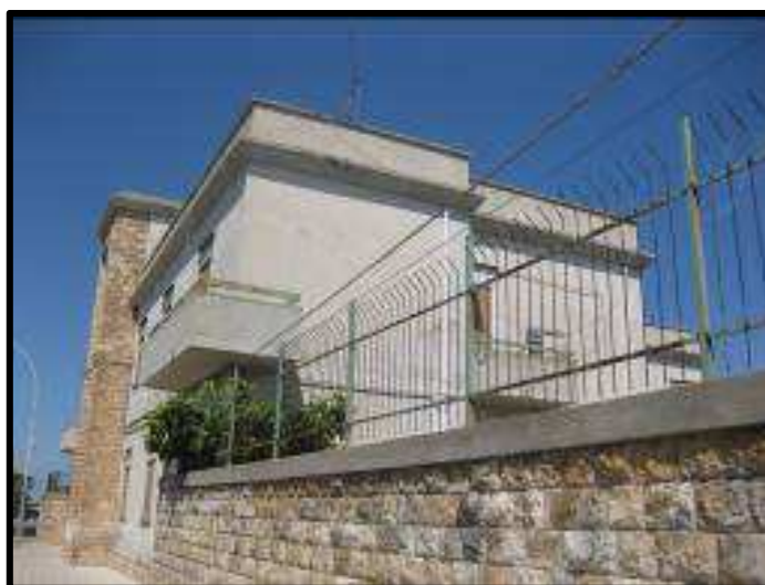
Fabbricato A, oggetto del presente Lotto 1
