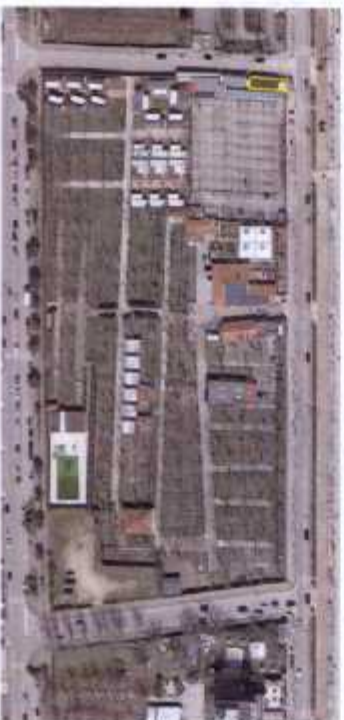
LOTTO N. 14: Sottomarina di Chioggia Scheda VEBP022 - C.T. Fig.37 Map. Il 2669 - 1832/Parte - Bazar - Negozio di mq. 39,00 c.a. e area scoperta di mq. 41 c.a. - Area sulla quale insiste un fabbricato in muratura di modesta qualità adibito a bazar e negozio. Lo stabile è ad un piano fuori terra con copertura prefabbricata. Le murature esterne sono intonacate. Sul fronte principale vi sono 4 vetrine che permettono anche l'accesso all'interno del manufatto direttamente da viale Ionio. Il fronte principale è ombreggiato con tendaggi e viene utilizzata parte del marciapiede come pertinenza del chiosco. Immobile di facile accesso. Stato occupazionale: Occupato.
