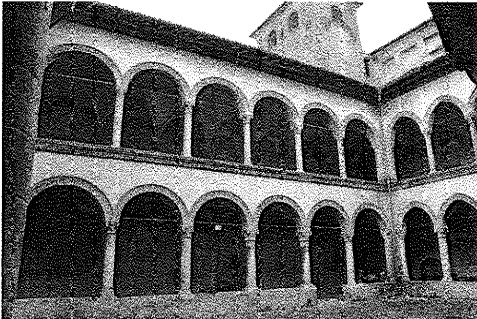
Foto n.1 Vista Chiostro interno (ante lavori)
