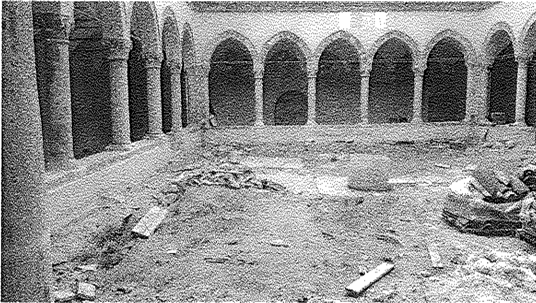
Foto n.5 Vista prospettico piano terra post lavori
