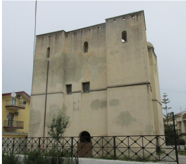
Torre del Cupo loc. Schiavonea di Corigliano Calabro, (CS)
