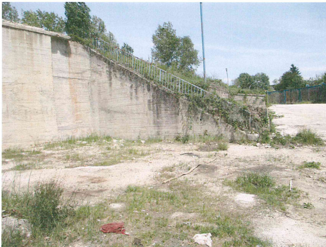
Foto 9 - muro in c.a. con elemento a cuneo di sostegno oggetto di demolizione
