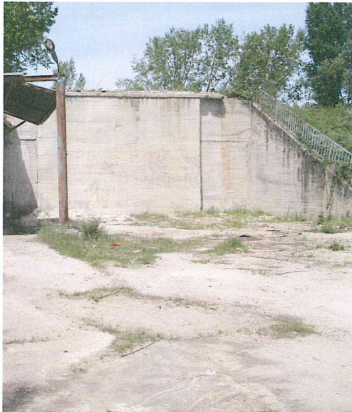
Foto 5 - muro in c.a. di contenimento di un terrapieno oggetto di demolizione
