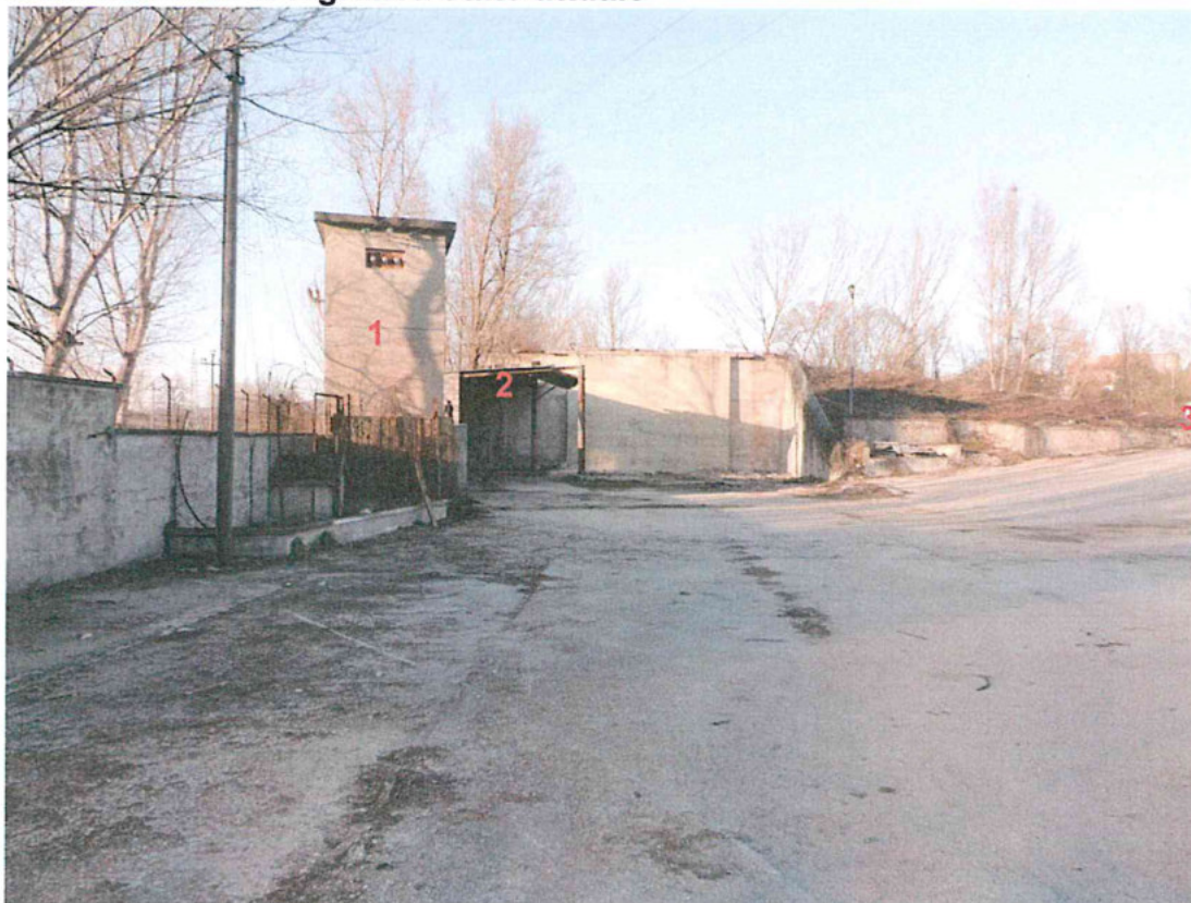
Foto 1 – ingresso dell'area con fabbricati nn. 1,2 e 3
