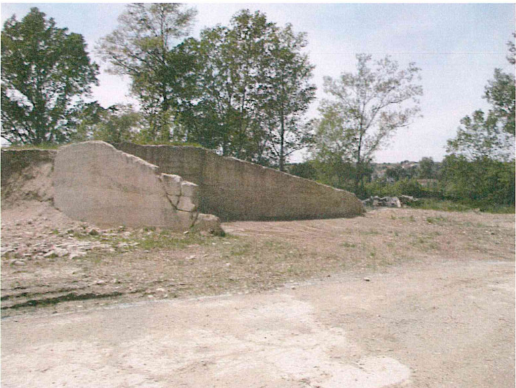
Foto 14 - setti in c.a. adibiti a spazio di carico per mezzi
