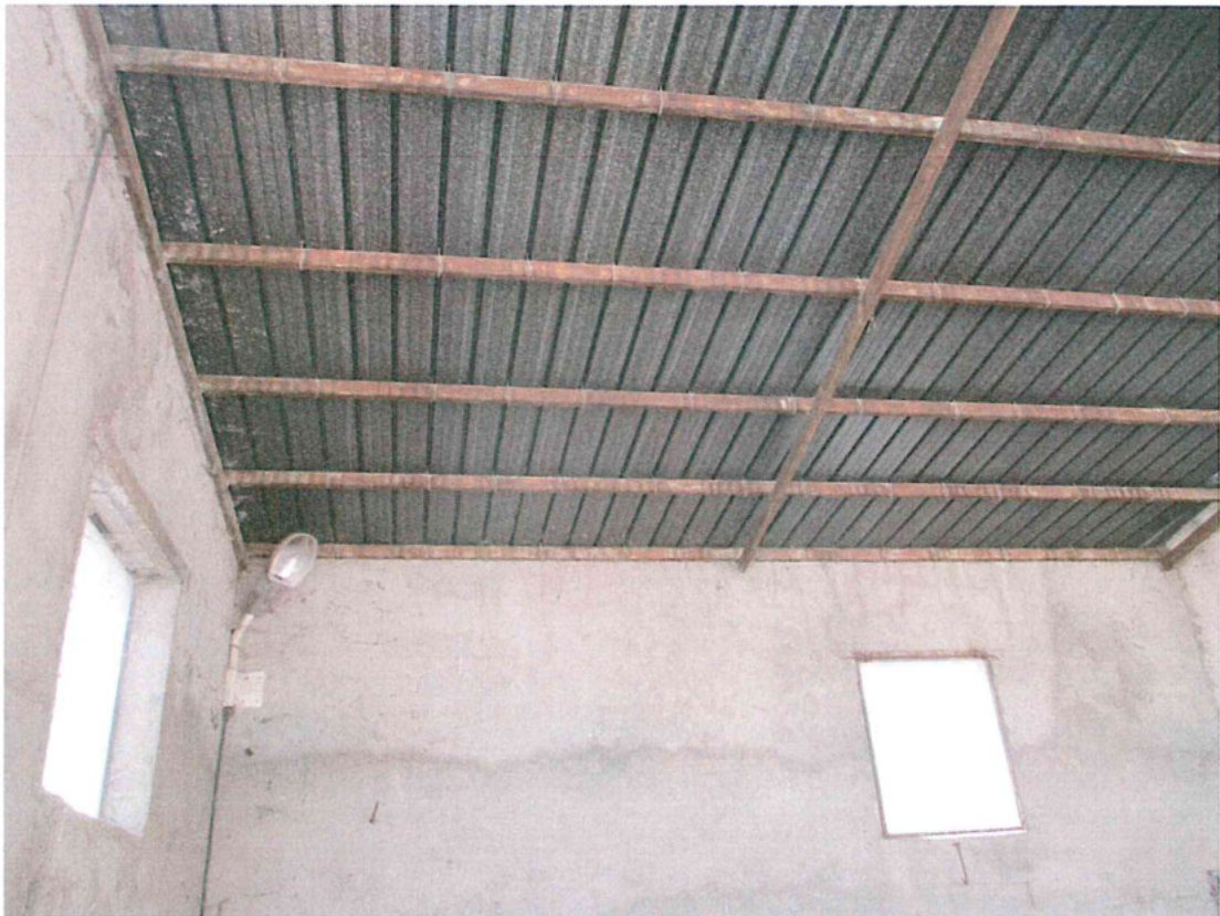
Foto 8 – particolare della copertura della pensilina metallica n. 3
