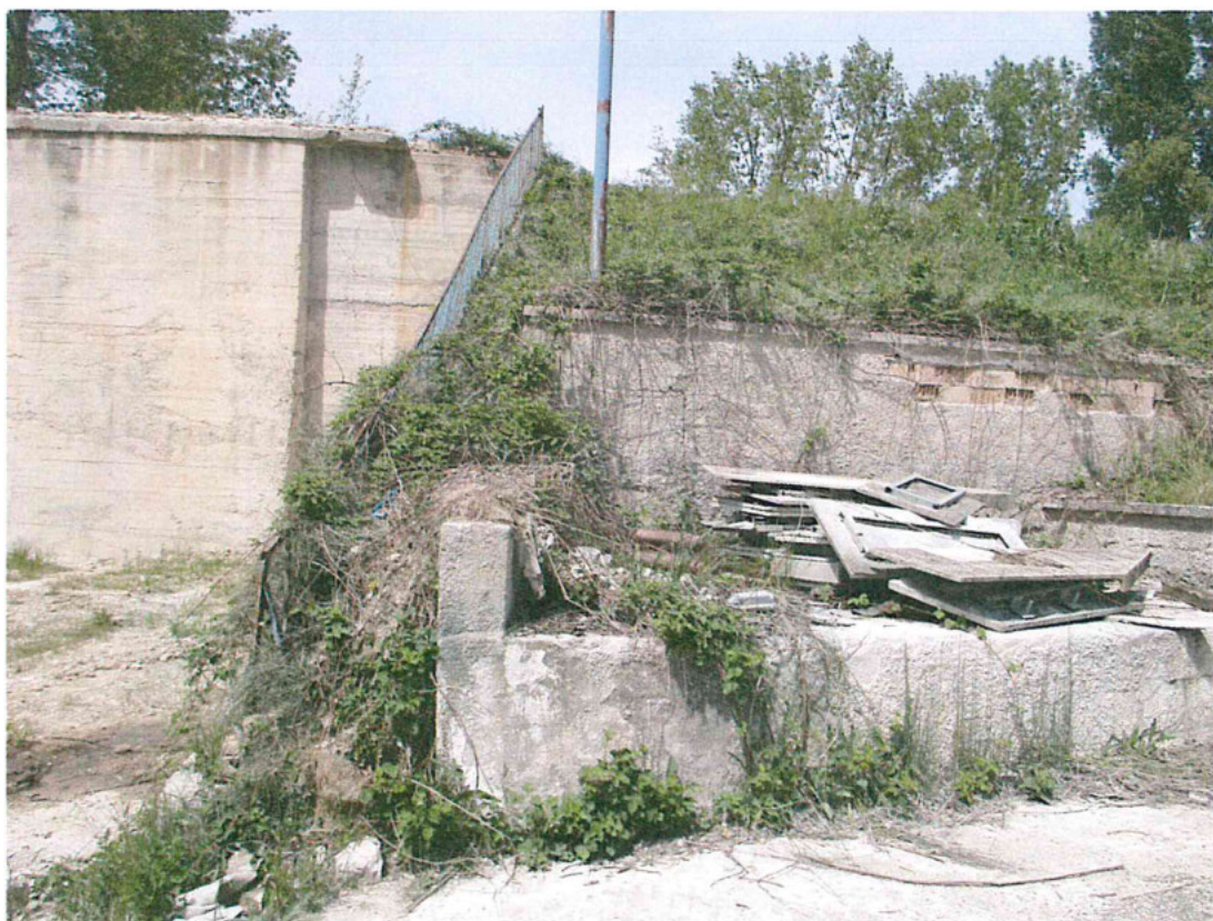
Foto 10 - materiale di scarto abbandonato da smaltire tra cui pannelli in amianto - eternit
