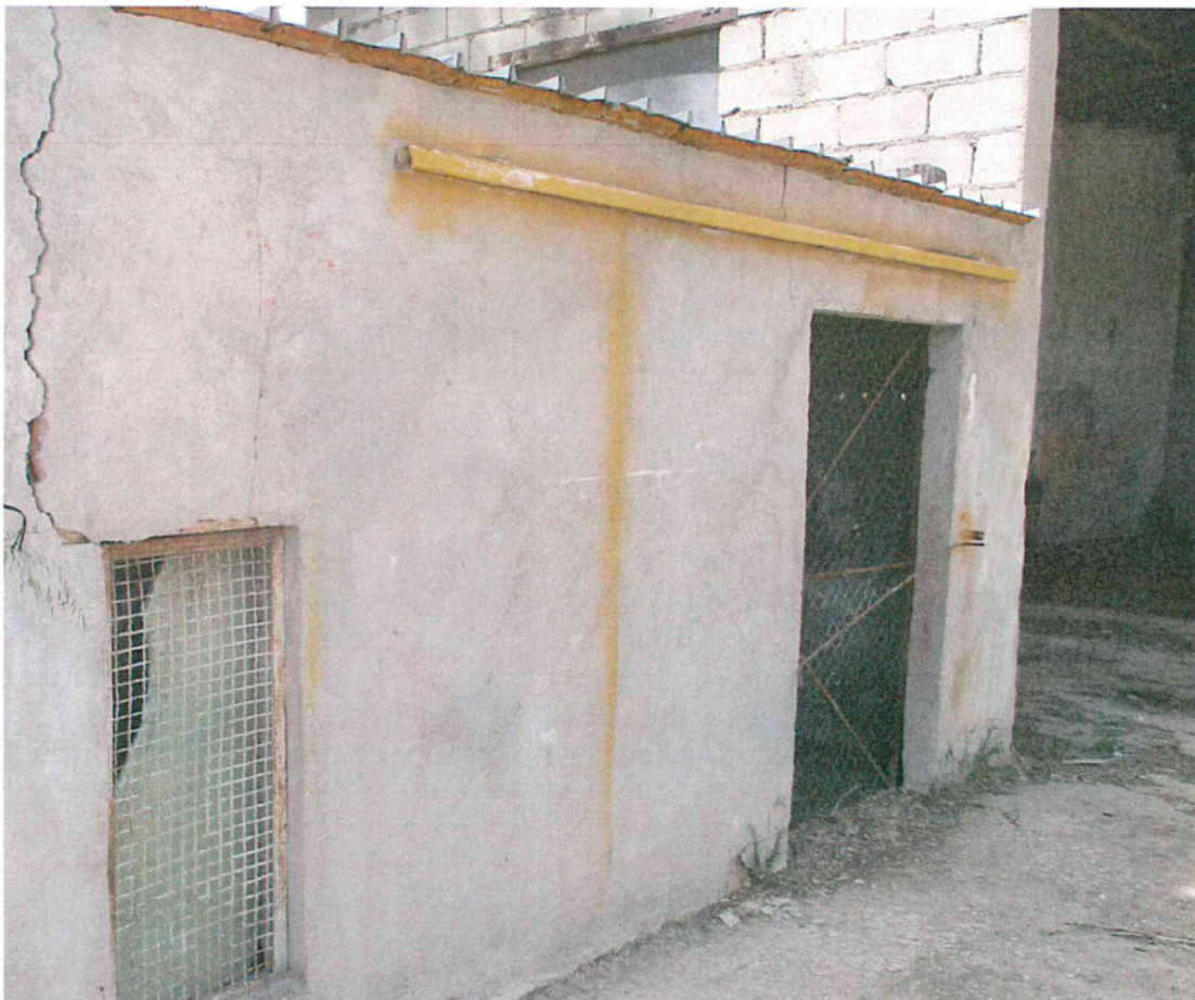
Foto 6 - manufatto in muratura (fabbricato n. 2) oggetto di demolizione
