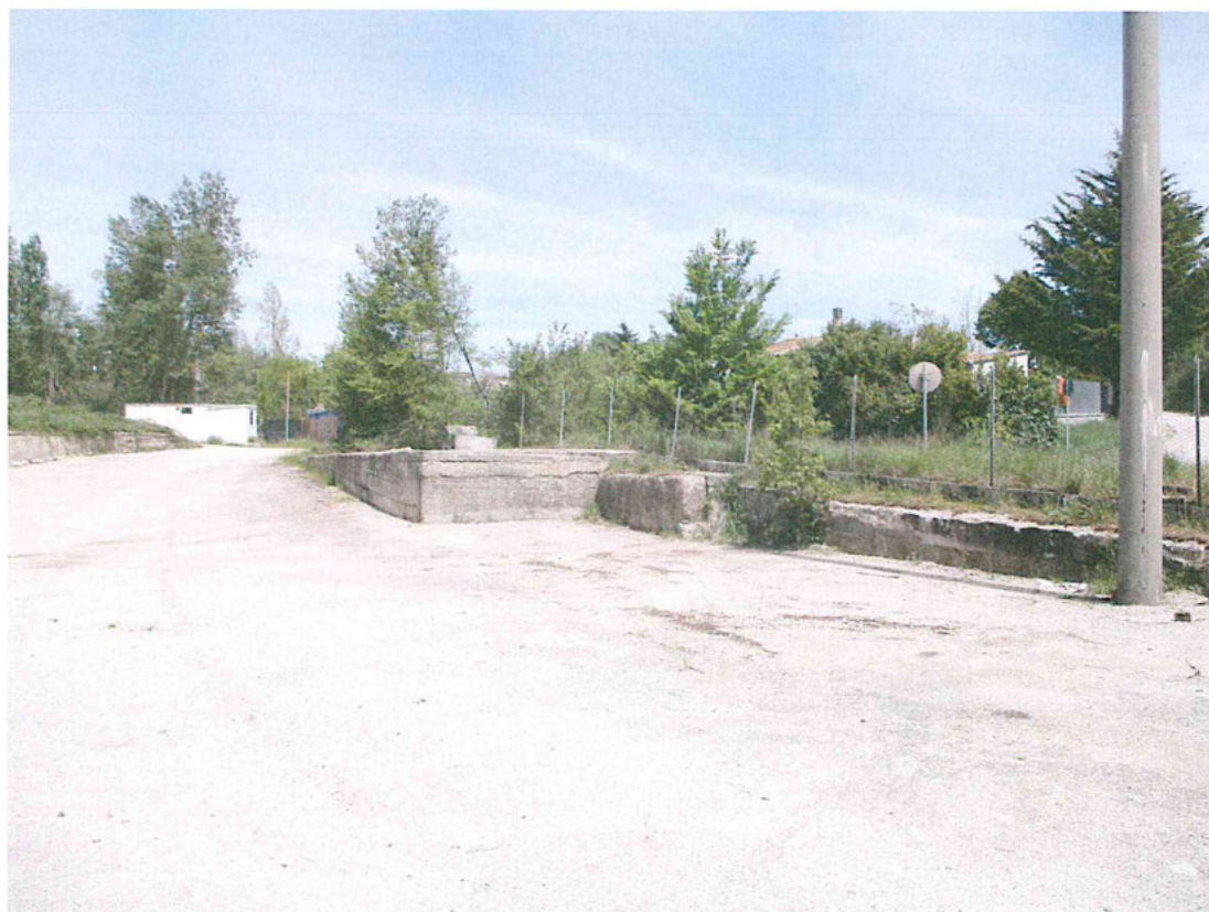
Foto 2 - rampa in c.a. oggetto di demolizione
