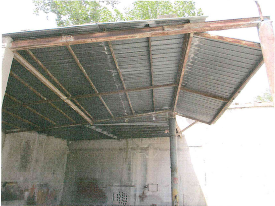
Foto 7 - pensilina metallica (fabbricato n. 3) oggetto di demolizione
