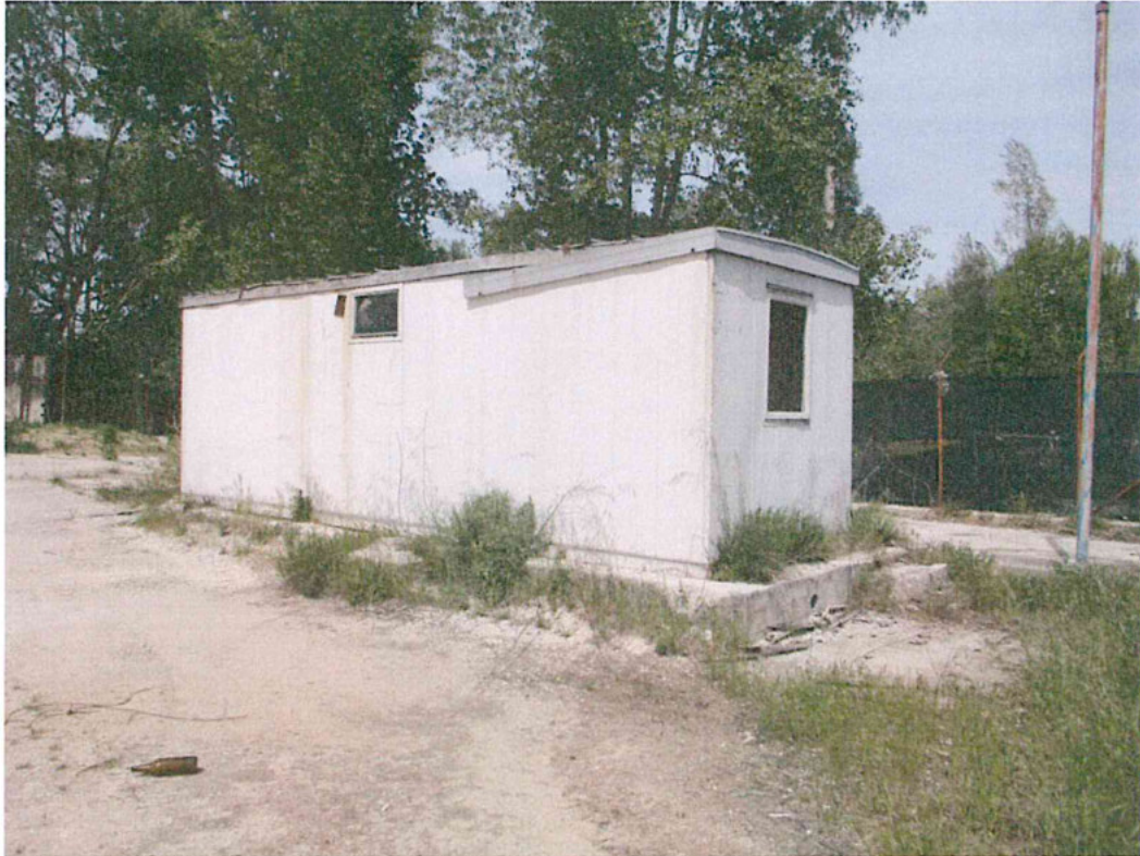
Foto 11 - box da cantiere prefabbricato oggetto di demolizione (fabbricato n. 3)
