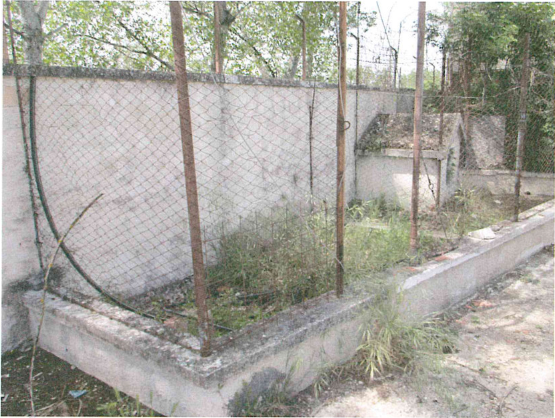
Foto 3- muretto con recinzione in corrispondenza dell'ingresso oggetto di demolizione
