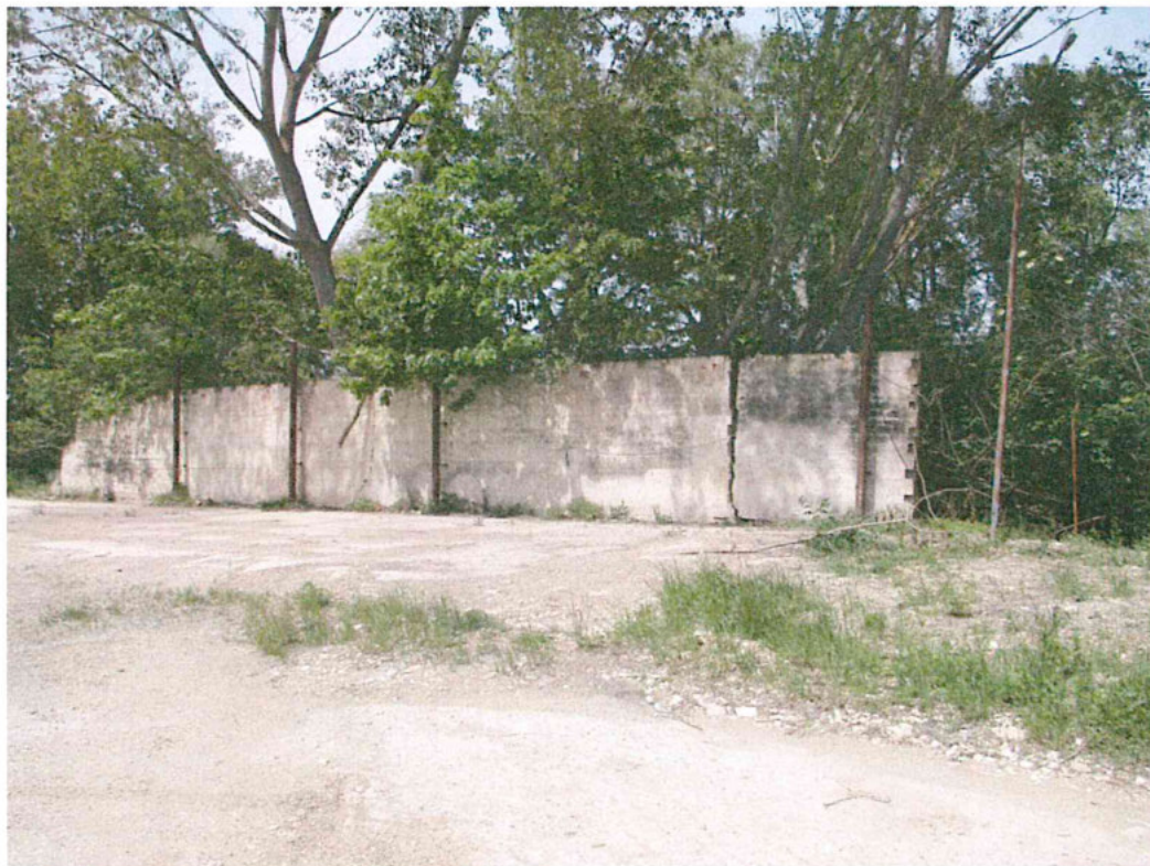
Foto 12 - muro in blocchetti di laterizio oggetto di demolizione
