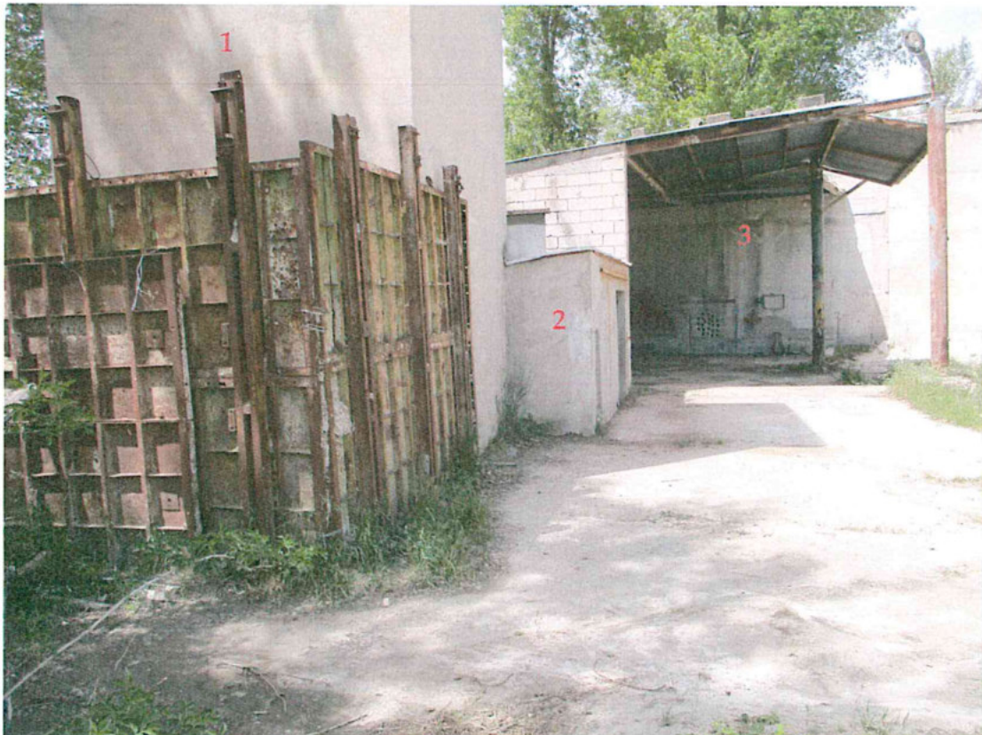
Foto 4 - cabina Enel (fabbricato n. 1) non da demolire e manufatti (fabbricato nn. 2 e 3) da demolire
