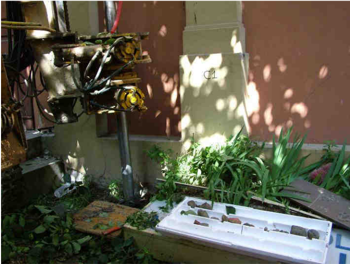
esecuzione del carotaggio C1
