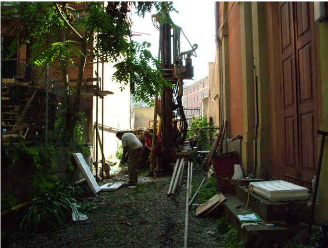
esecuzione del sondaggio geognostico S2
