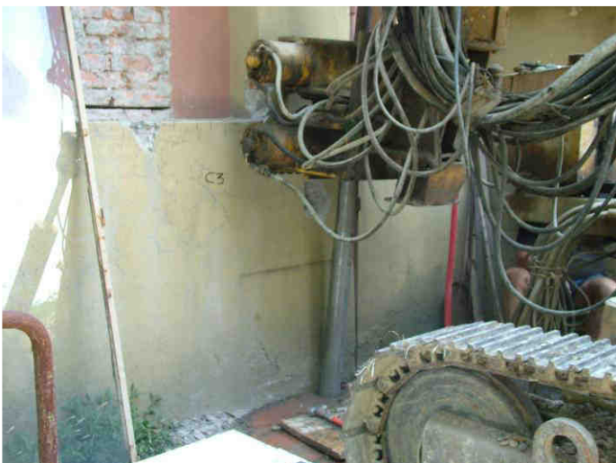
esecuzione del carotaggio C3
