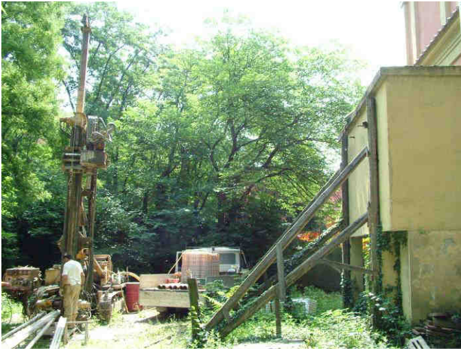
esecuzione del sondaggio geognostico S1
