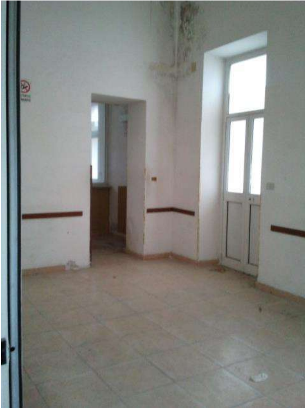
Imbibizione strutture verticali
