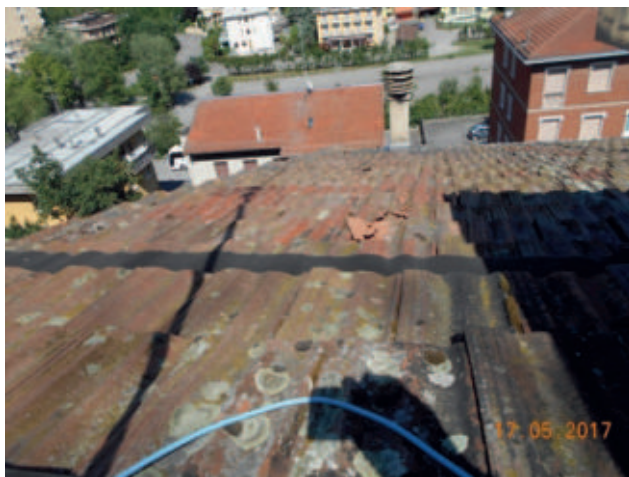
Foto 3125 - Particolare del manto di copertura con tegole marsigliesi
