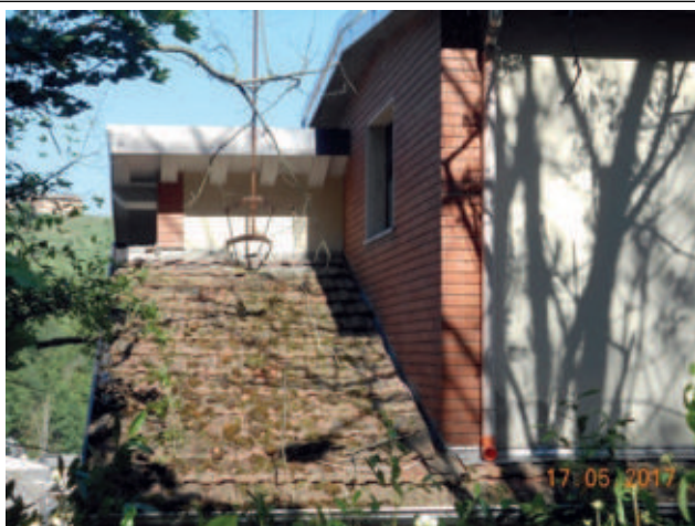
Foto 3223 - Particolare copertura e locale macchine ascensore
