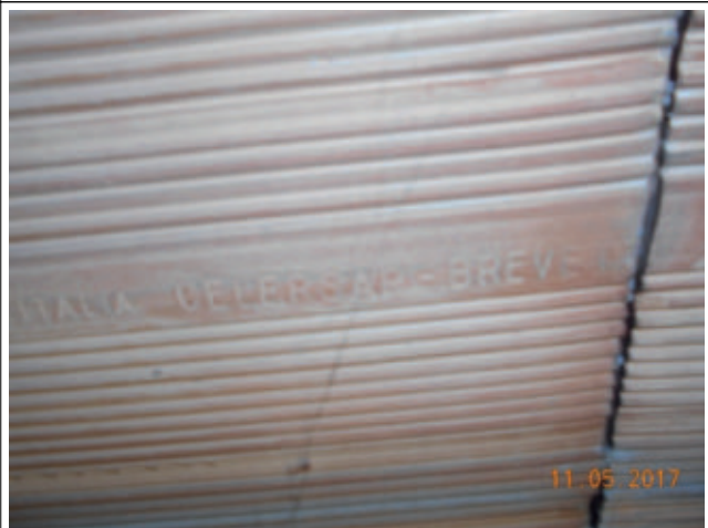
Foto 3014 – Particolare tipologia mattoni semipieni pareti portanti BREVETTO CELERSAP
