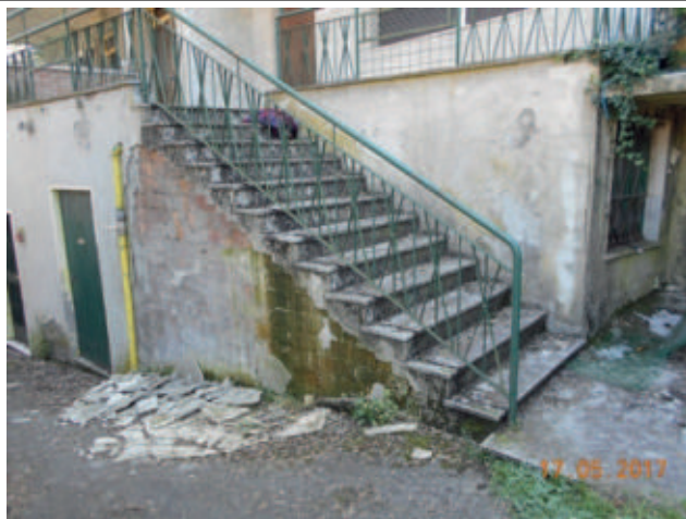
Foto 3209 – Scala esterna (struttura in mattoni semipieni)
