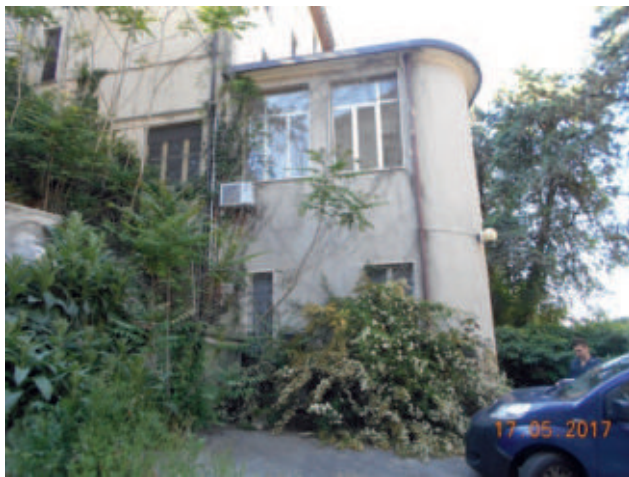
Foto 3216 - Vista Prospetto laterale sinistro
