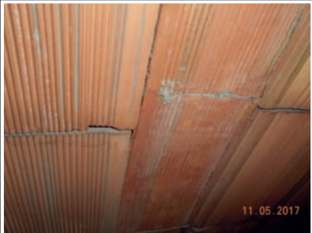
Foto 3012 – Particolare solaio in laterocemento con travetti prefabbricati “CELERSAP” e Pignatte “RDB”
