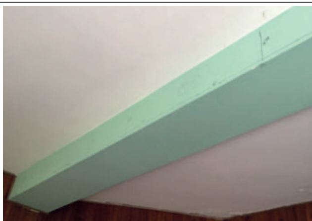
Foto 8420 – Trave ricalata in cemento armato nel soggiorno al piano terra
