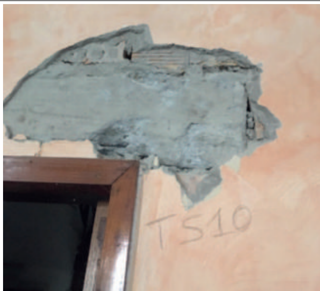
Foto 8393 (Saggio TS10) – Architrave sopra porta
