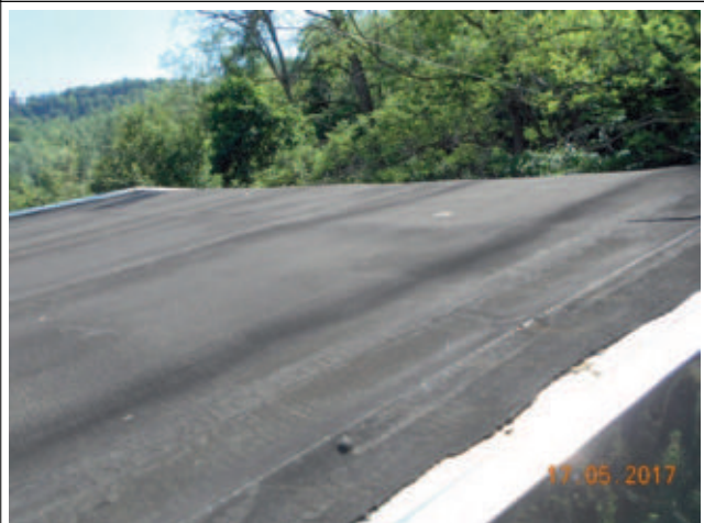
Foto 3217 - Copertura del locale macchine ascensore
