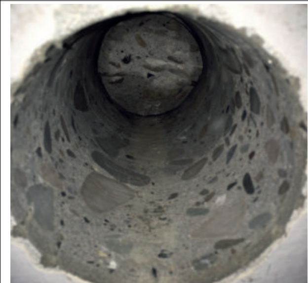
Foto 8419 (Carotaggio TC1) – Parete controterra in calcestruzzo non armato
