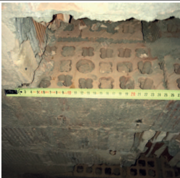
Foto 8455 – Particolare tipologia mattoni semipieni pareti portanti
