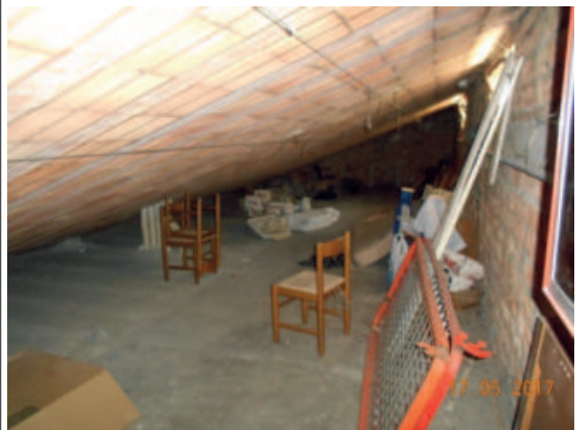
Foto 3112 - Solaio di copertura (soffitta)
