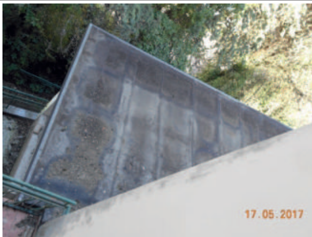
Foto 3185 – Copertura della Veranda
