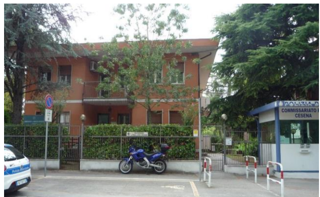
Ingresso Commissariato palazzina B
