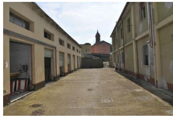
Accesso di servizio al fabbricato H
