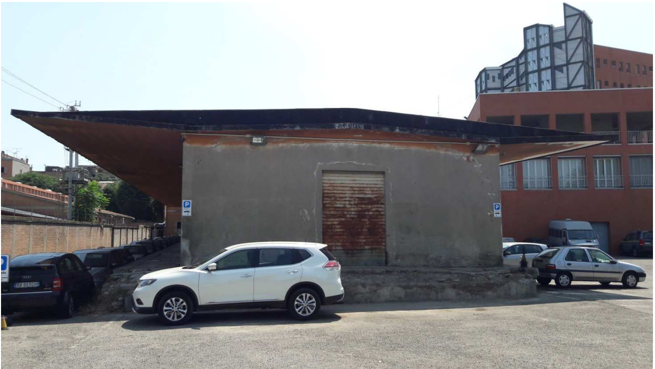
Corpo Magazzino Prospetto Ovest
