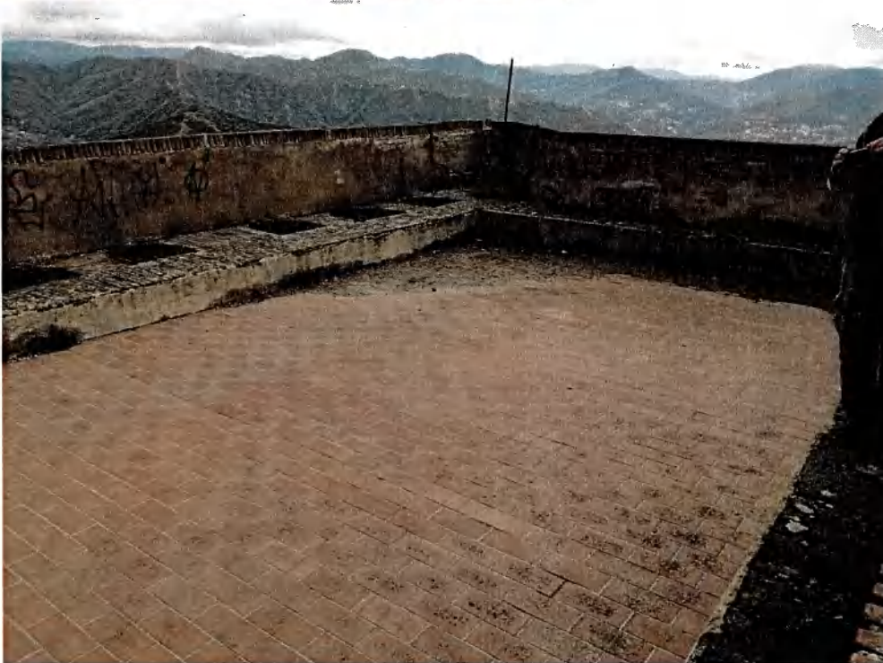
Fig. 8 Copertura piana della caserma – vista angolo Nord-Est
