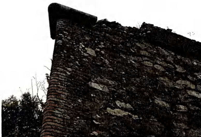
Fig. 16 Materiale lapideo instabile sulla cinta muraria interna lato Nord-Ovest
