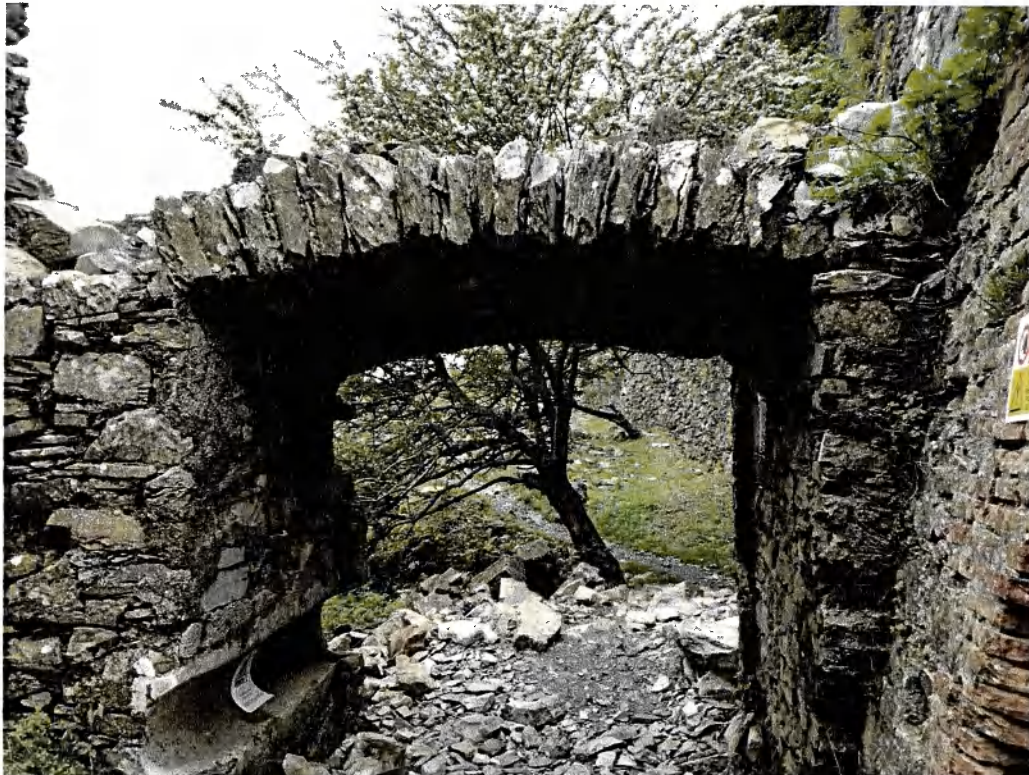
Fig. 4 Contrafforte ad arco lato Ovest
