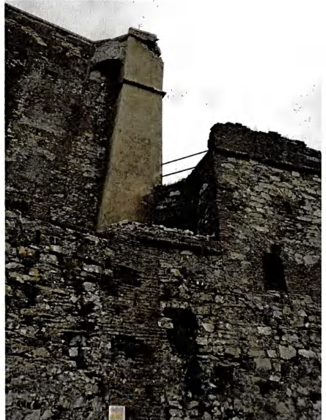
Fig. 15 Fronte torre-caserma prospiciente percorso esterno a Est
