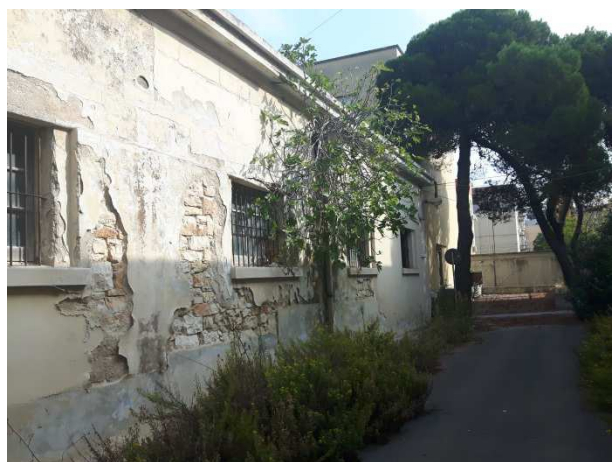
Foto 4 - Prospetto Sud, particolare
