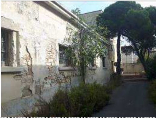
Foto 5 - Prospetto Sud - particolare
