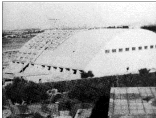
Figura 3 - Aeroporto di Pontecagnano 1941 - 1942 si procede alla copertura dell'Aviorimessa con tegole di eternit.
