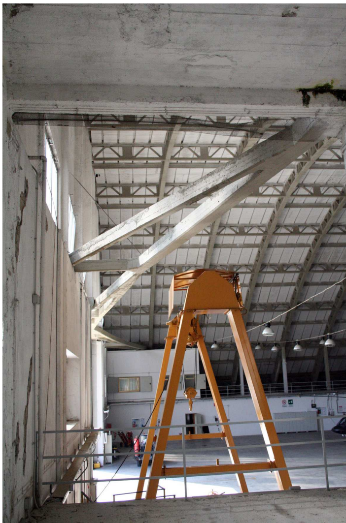
Figura 19 – Particolare trave reticolare orizzontale.
