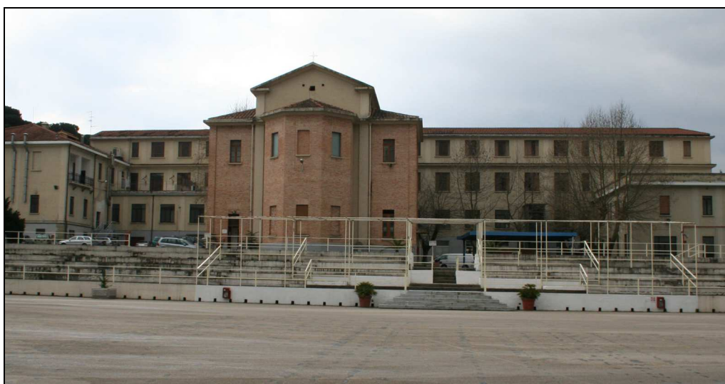
Figura 34 – Palazzina 8 , cappella vista dall'esterno.
