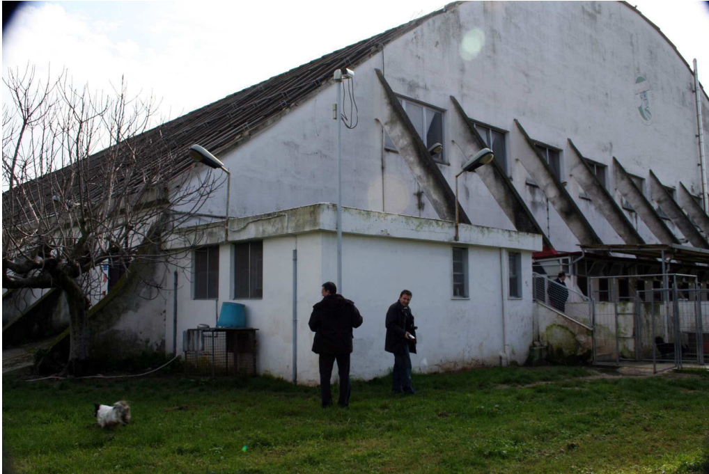
Figura 17 – Particolare lato posteriore HANGAR controventato.
