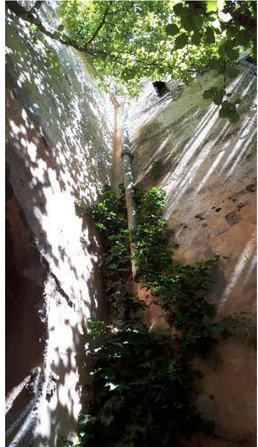
Lastre e pluviali nella corte n. 1 in cemento amianto da rimuovere.
