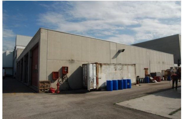
Foto 18: lato sud - ovest corpo D
