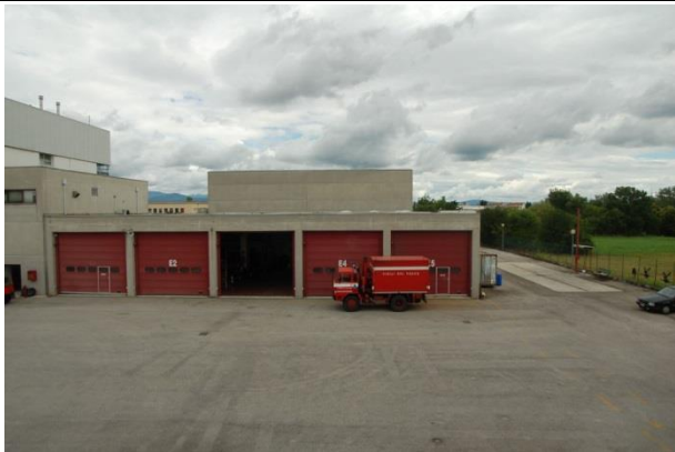
Foto 19: lato ovest corpo D
