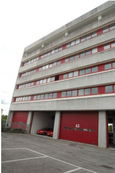
Foto 11: lato nord Corpo B verso est
