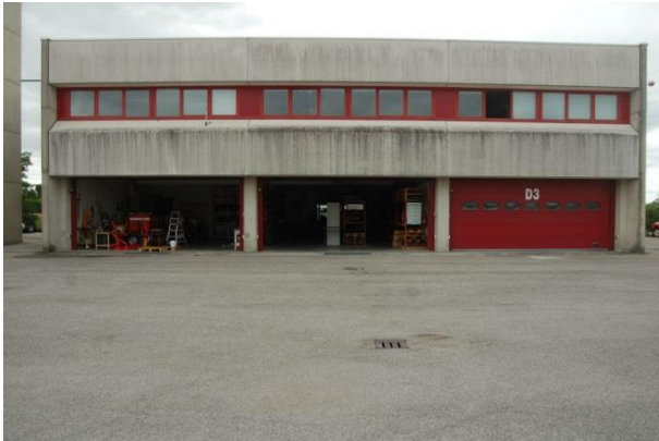
Foto 23: corpo F lato nord
