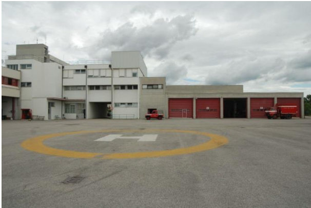
Foto 7: Corpo A e D lato ovest
