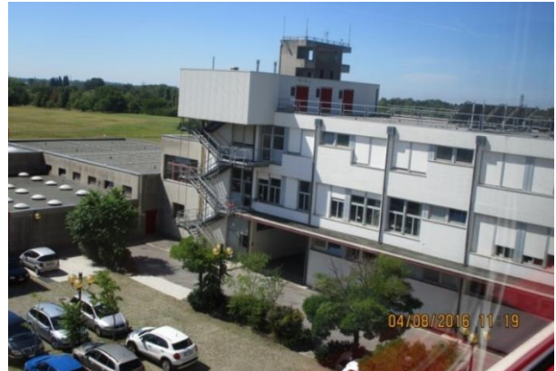
Foto 4: esterno Corpo A lato est
