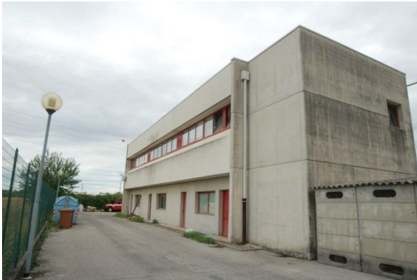
Foto 25: lati Sud ed Est Corpo F
