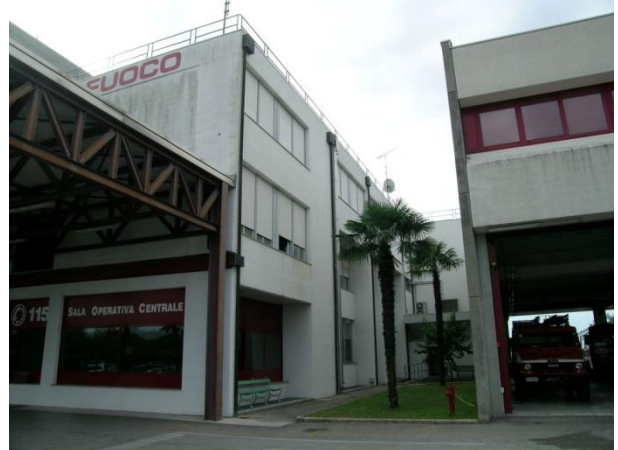
Foto 8: Corpo A lato nord-ovest
