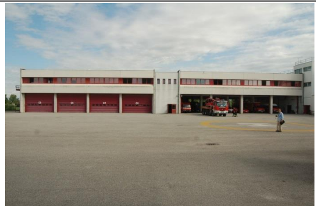
Foto 16: lato sud corpo C
