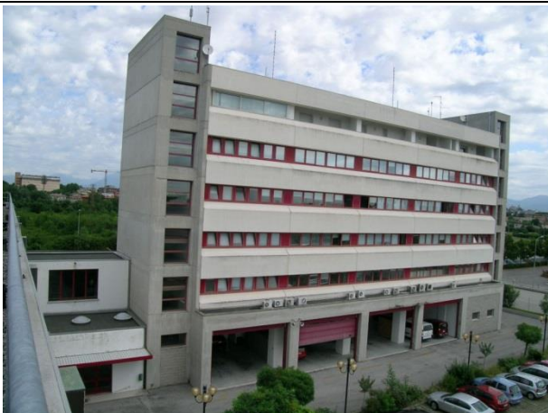
Foto 13: lato sud ovest Corpo B
