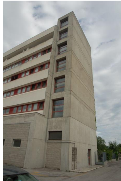
Foto 12: lato est sud Corpo B
