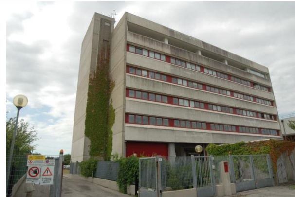
Foto 9: Corpo B lato nord est
