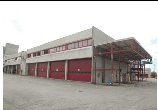
Foto 14: lato nord ovest corpo C
