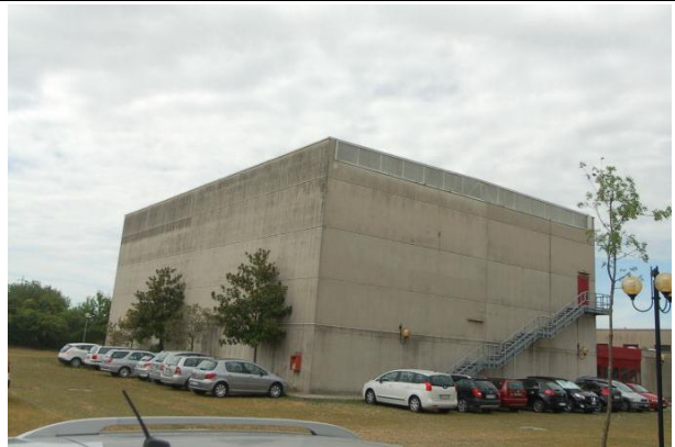
Foto 20: lati nord-est Corpo E
