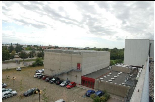
Foto 22: Lato nord vista dall'alto Corpo E
