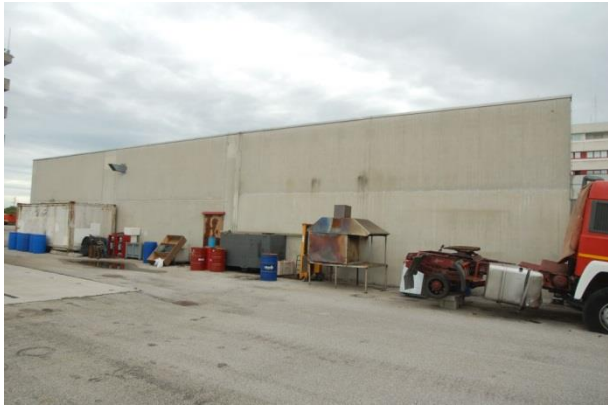
Foto 17: lato sud corpi D ed E
