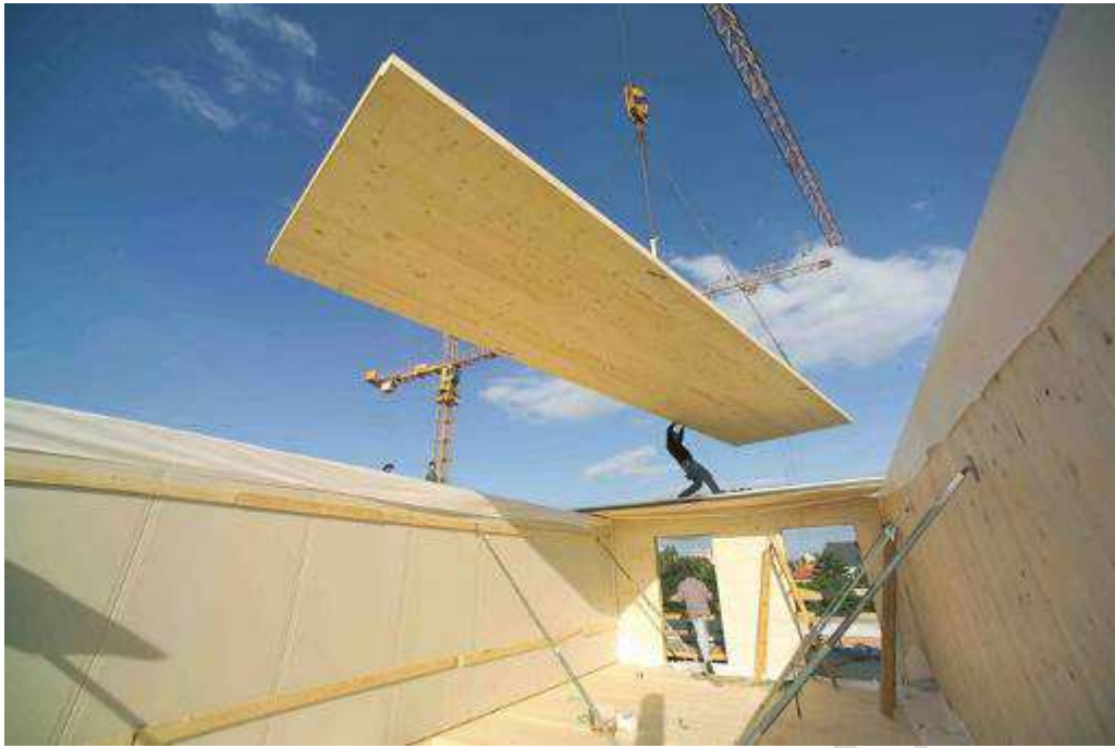
Esempio montaggio pannelli XLam
