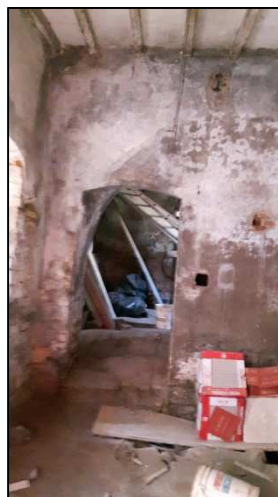
Foto 8: Vano al p.t.
