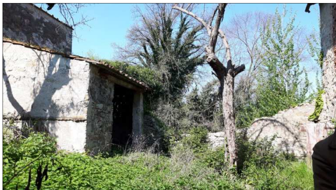
Foto 7: Manufatto nella corte interna
