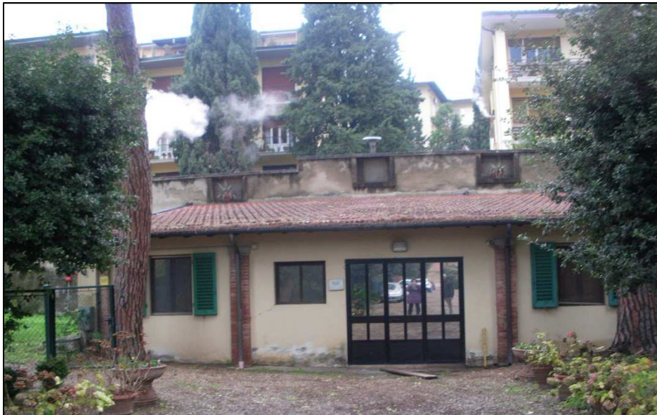
Vista del fabbricato “uffici e spogliatoi giardinieri”
