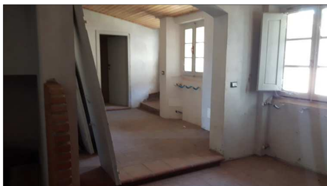
Foto 11: Vano al p. 1°
