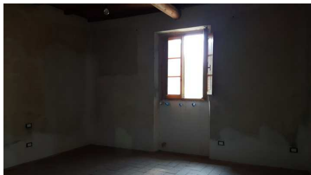
Foto 17: Vano al p. 1°
