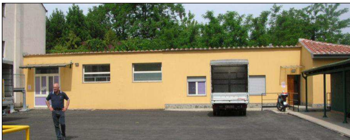
Corpo di fabbrica principale
