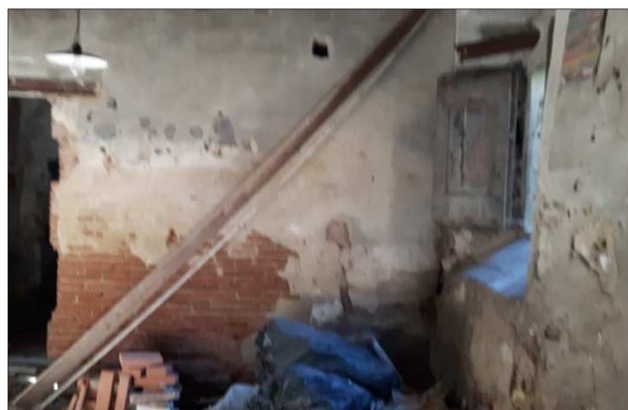
Foto 10: Vano al p.t.
