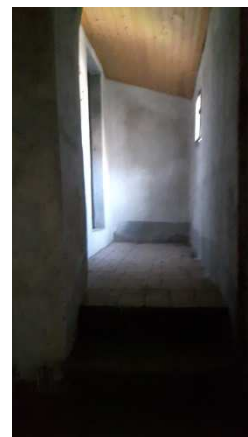
Foto 18: Vano al p. 1°
