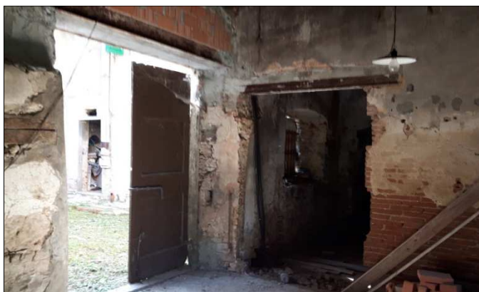
Foto 9: Vano al p.t.
