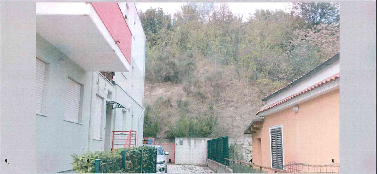
FOTO 03 – Fronte della scarpata – vista lato est del fabbricato
