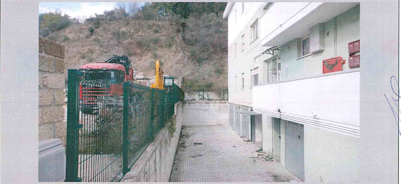
FOTO 02 –Fronte della scarpata – vista lato ovest del fabbricato
