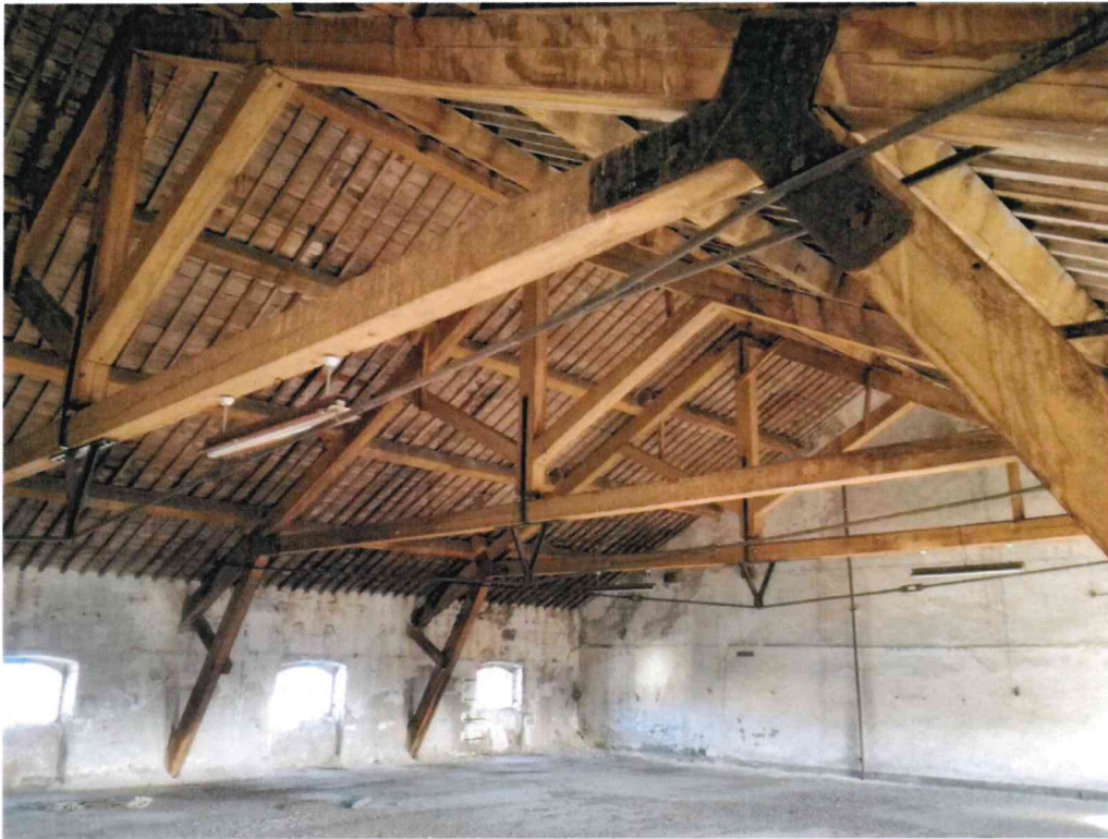
Fig. 7 – Intradosso solaio di copertura del fabbricato "1" (parte centrale – vista verso Sud-Ovest)
