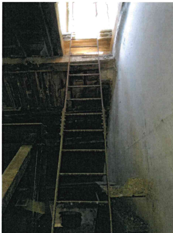
Fig. 6 – Scaletta di accesso alla copertura del fabbricato "1"
