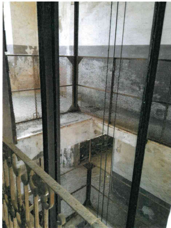
Fig. 10 – Scala a Est di accesso al locale tecnico in copertura del fabbricato "3"
