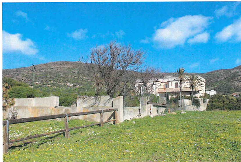
Palazzina Sanità e muro di cinta
