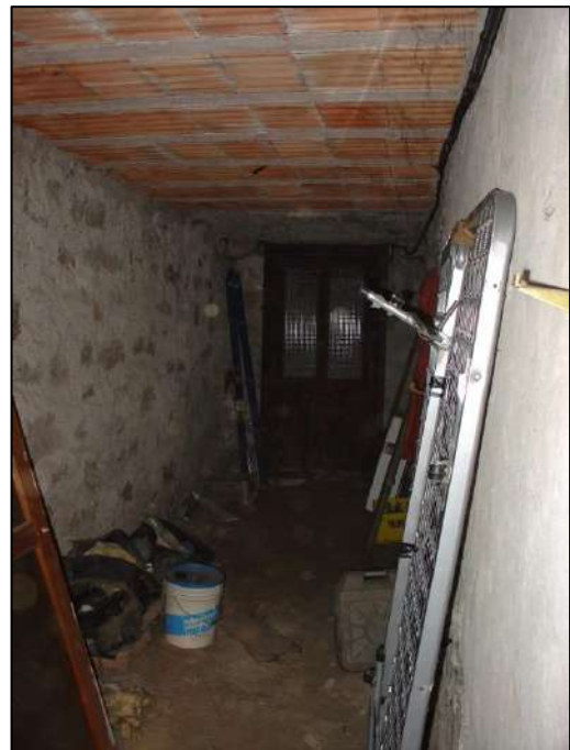
Foto 8: Interno piano interrato
