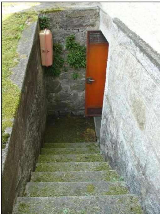
Foto 7: Scala accesso piano interrato
