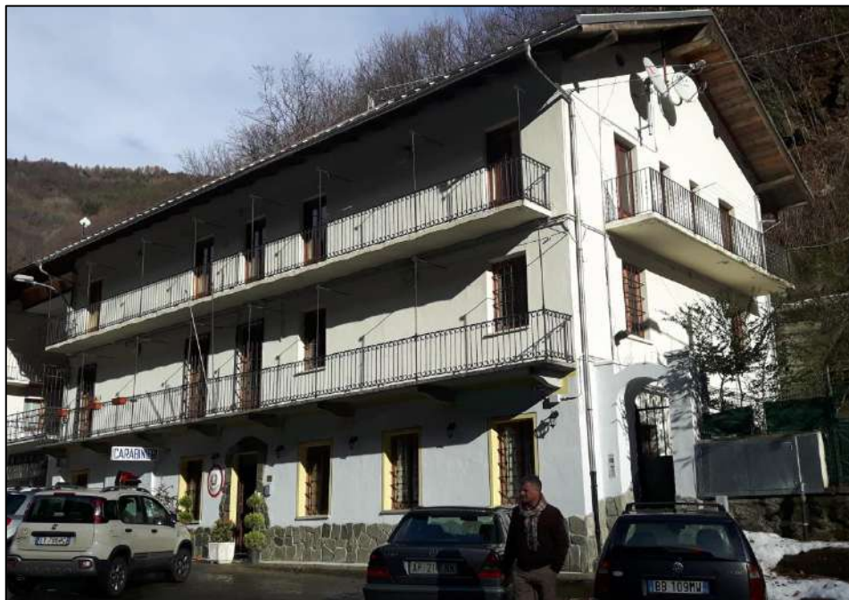
Foto 1: Ingresso, vista esterna
