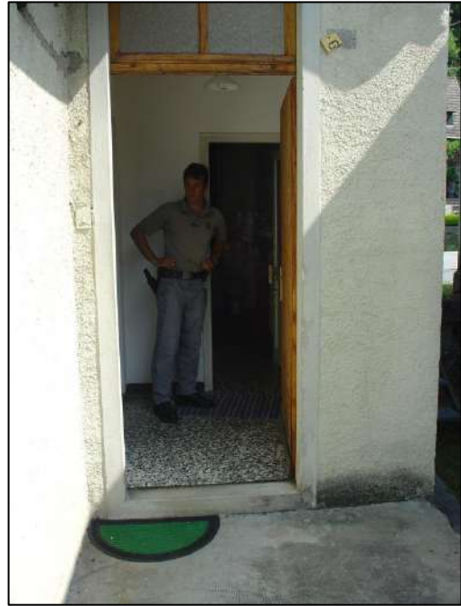
Foto 6: Accesso piano primo
