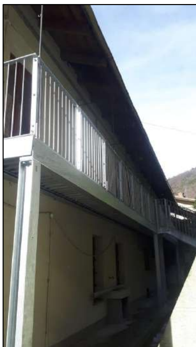
Foto 5: Vista esterna, retro fabbricato
