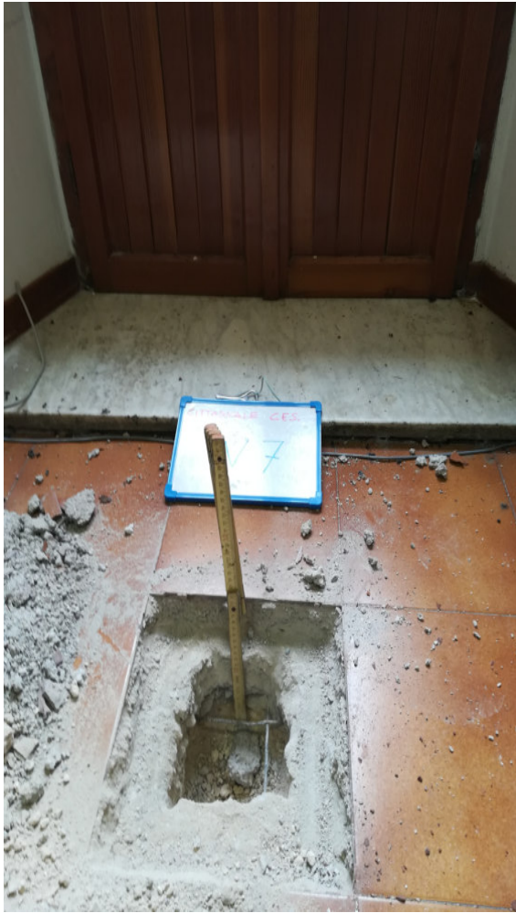
Foto n.11- INDAGINE VISIVA IV 7
