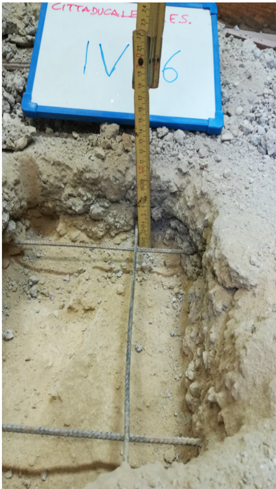
Foto n.26- INDAGINE VISIVA IV 16
