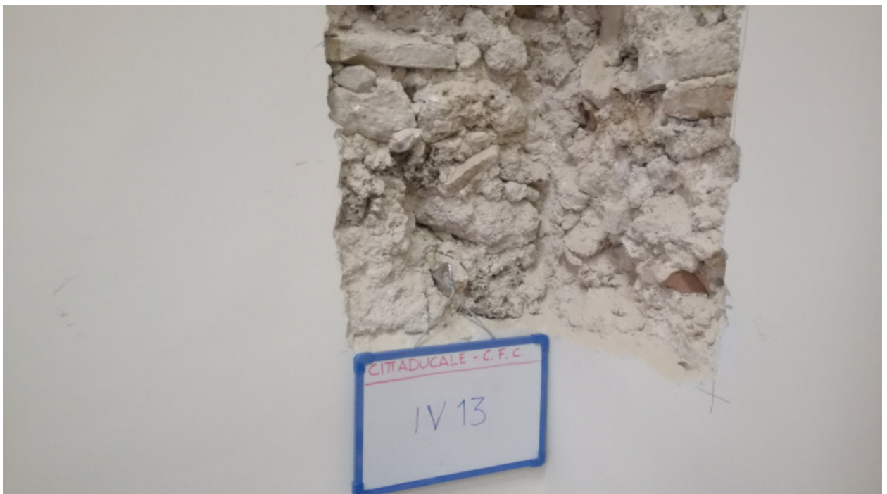
Foto n.20- INDAGINE VISIVA IV 13
