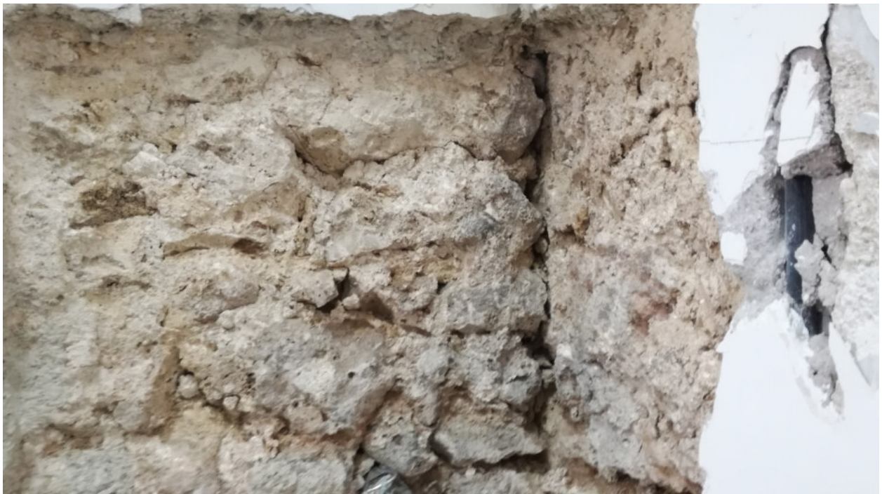
Foto n.6– INDAGINE VISIVA IV 3
