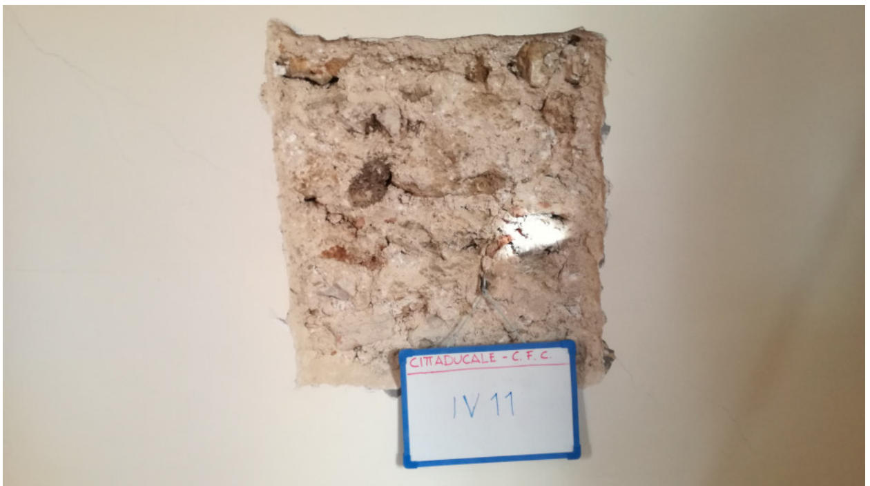
Foto n.16- INDAGINE VISIVA IV 11
