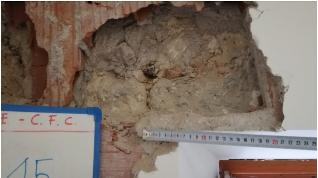
Foto n.24- INDAGINE VISIVA IV 15
