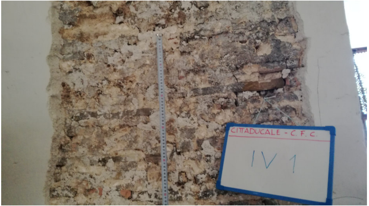
Foto n.1 – INDAGINE VISIVA IV 1
