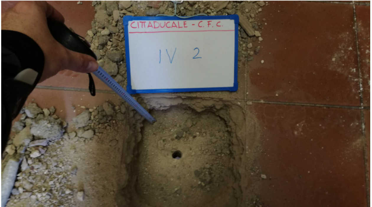
Foto n.3 – INDAGINE VISIVA IV 2
