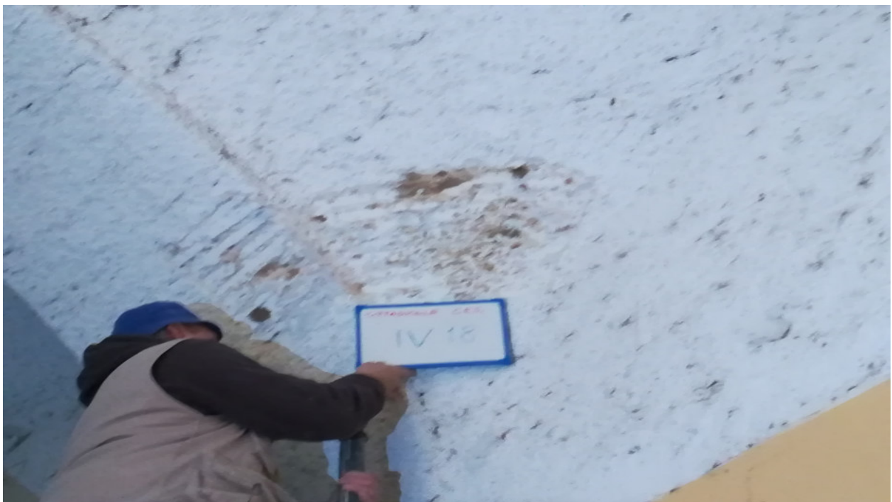
Foto n.28- INDAGINE VISIVA IV 18
