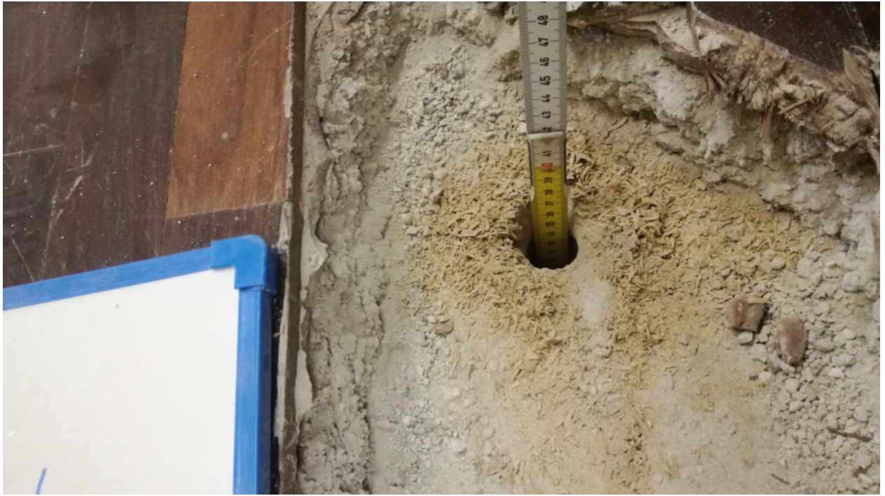
Foto n.19- INDAGINE VISIVA IV 12
