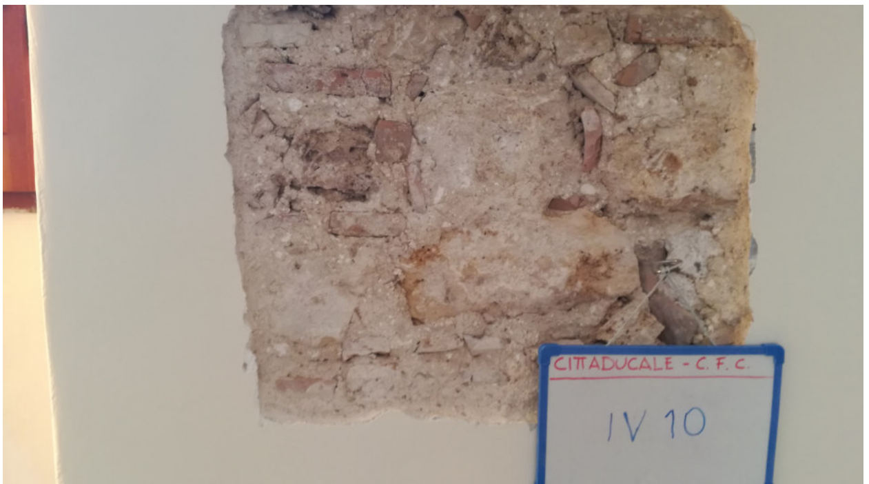
Foto n.14- INDAGINE VISIVA IV 10
