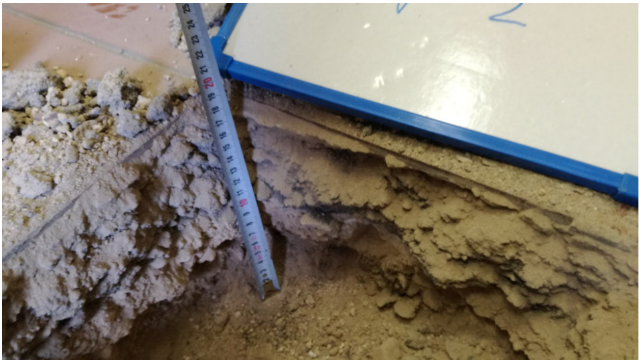
Foto n.4 – INDAGINE VISIVA IV 2
