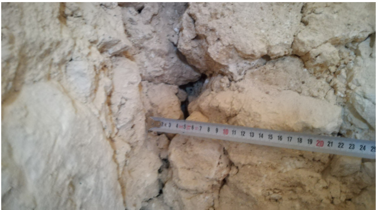
Foto n.22- INDAGINE VISIVA IV 14
