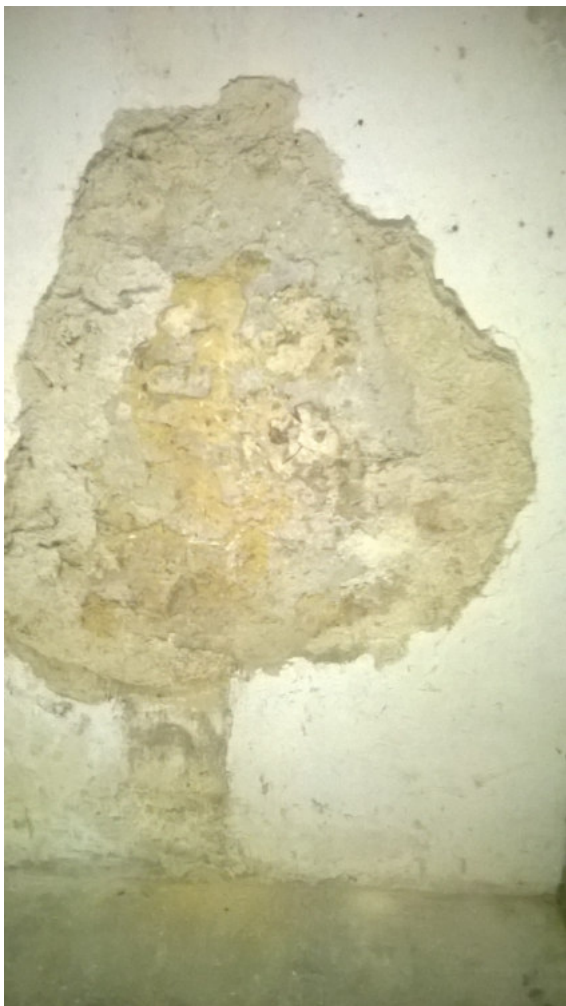
Foto n.10- INDAGINE VISIVA IV 6
