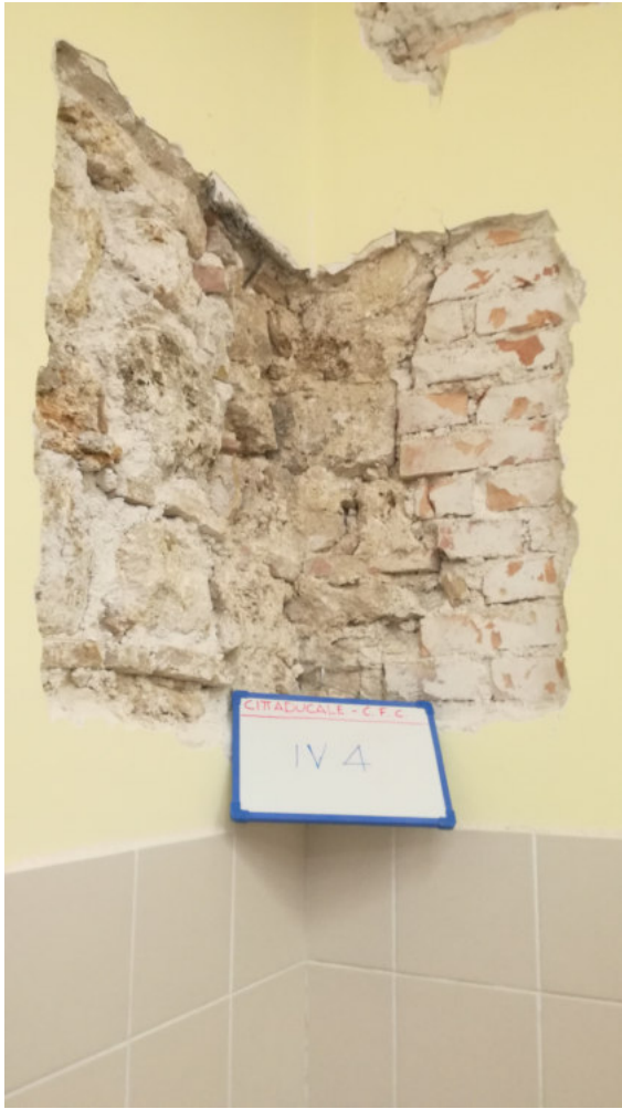
Foto n.7- I INDAGINE VISIVA IV 4
