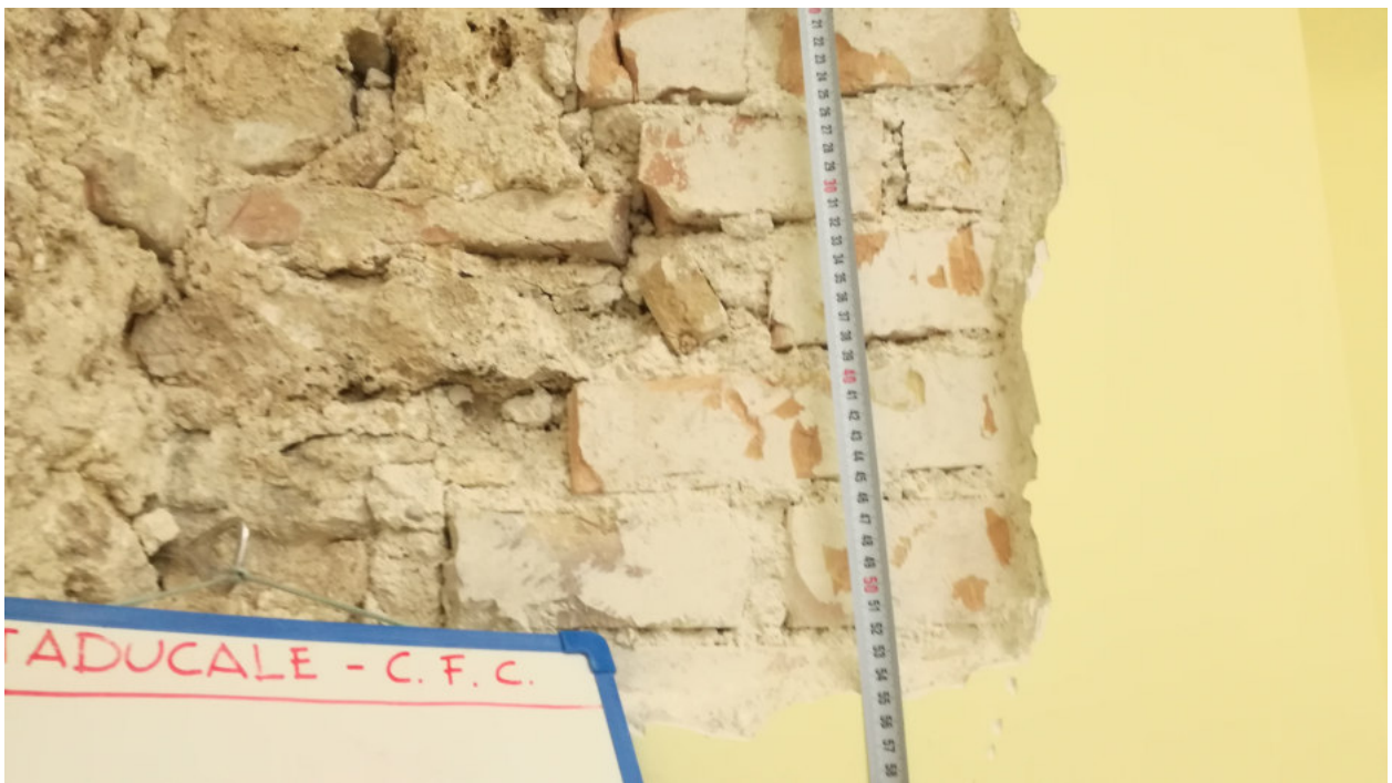
Foto n.8- INDAGINE VISIVA IV 4
