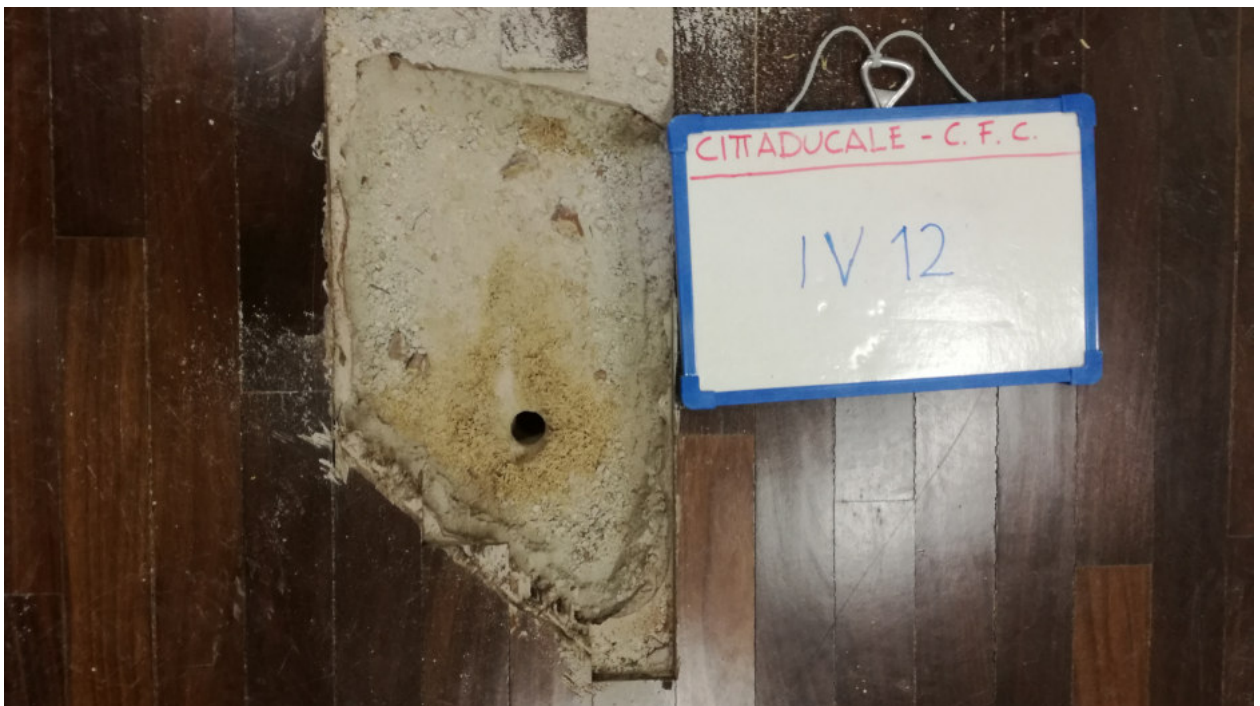
Foto n.18- INDAGINE VISIVA IV 12
