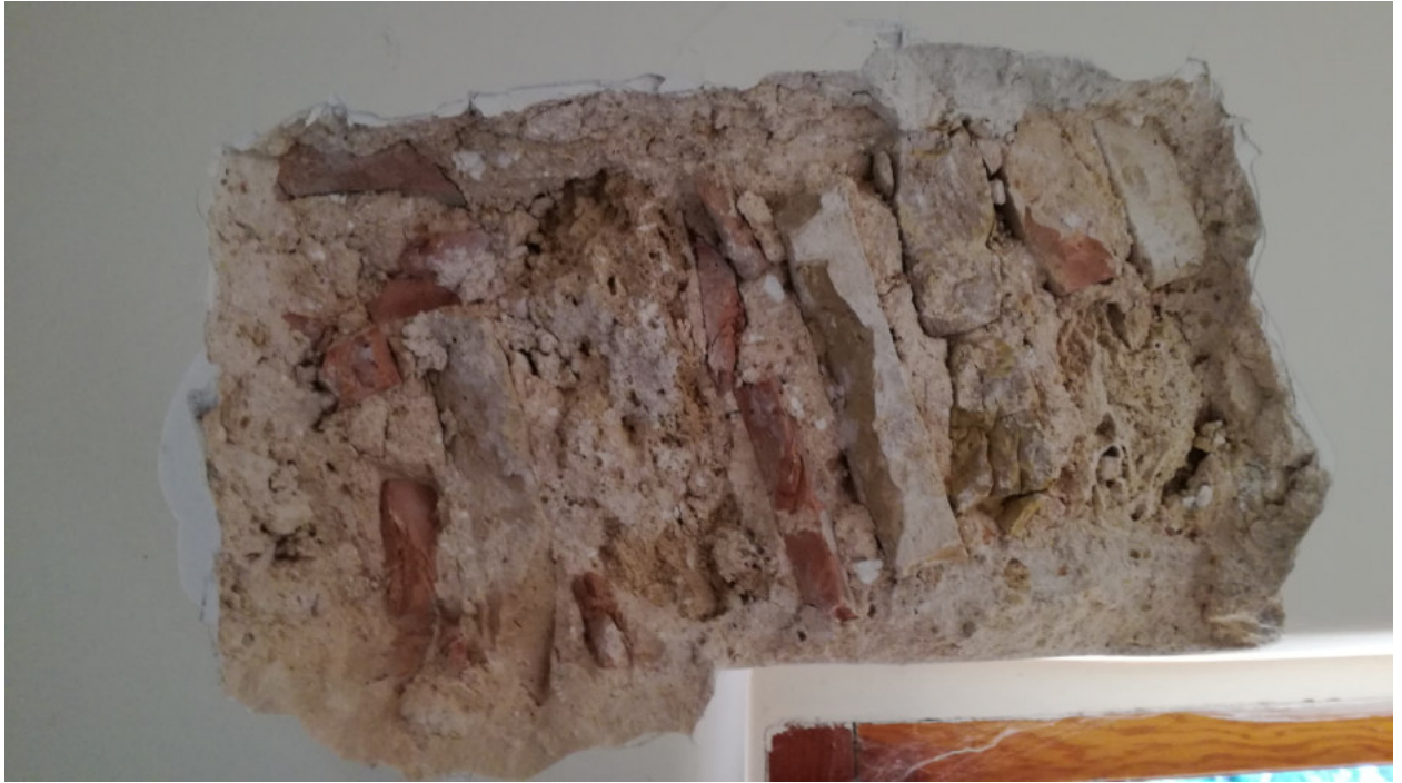
Foto n.13- INDAGINE VISIVA IV 9
