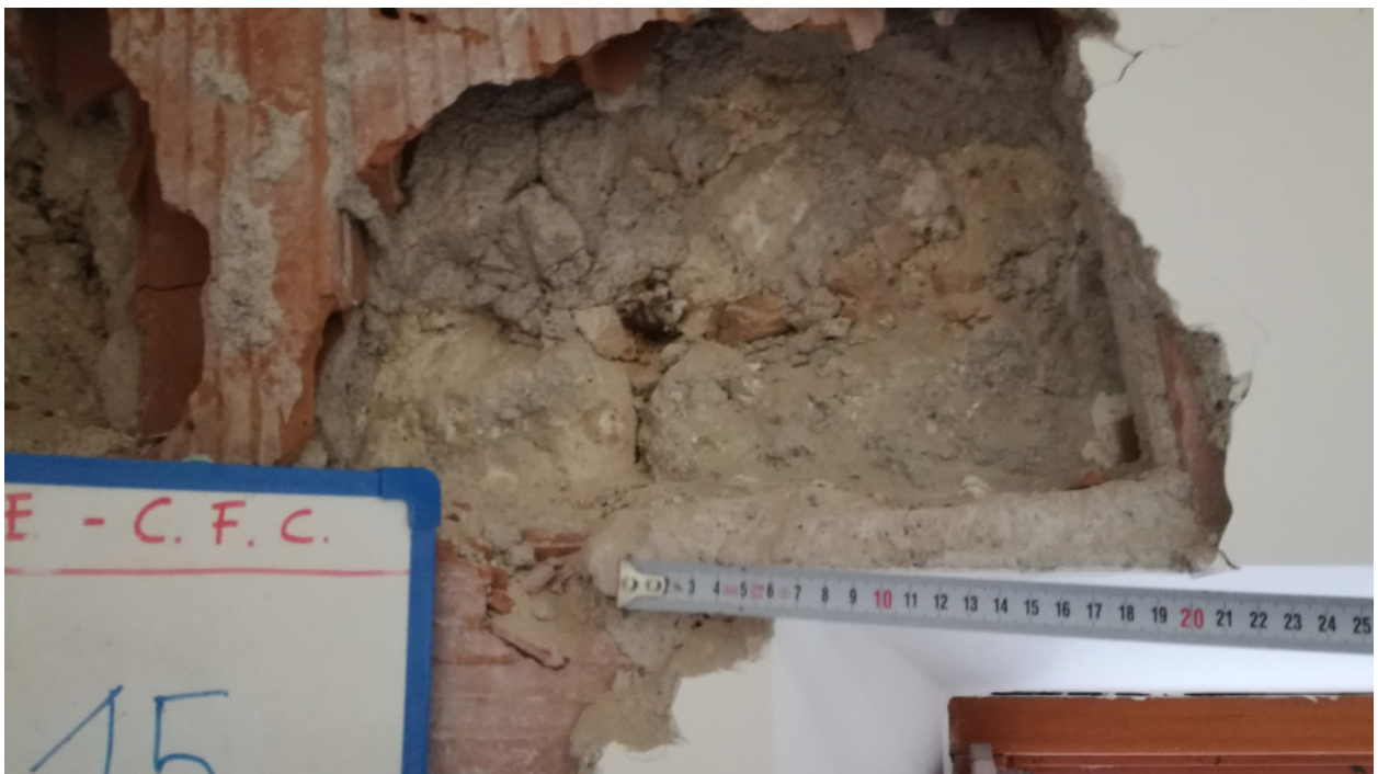
Foto n.24- INDAGINE VISIVA IV 15
