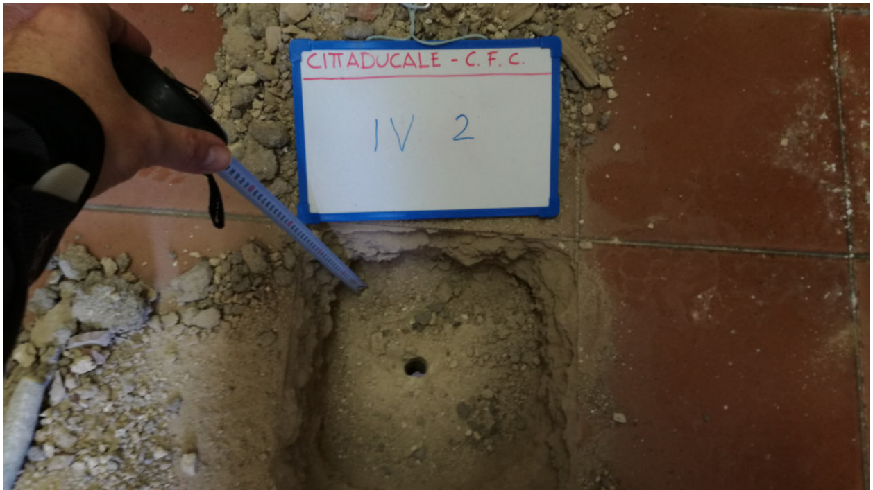
Foto n.3 – INDAGINE VISIVA IV 2
