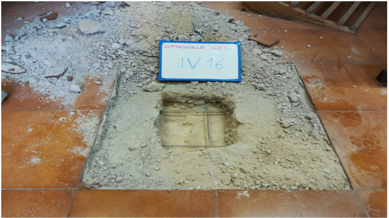
Foto n.25- INDAGINE VISIVA IV 16
