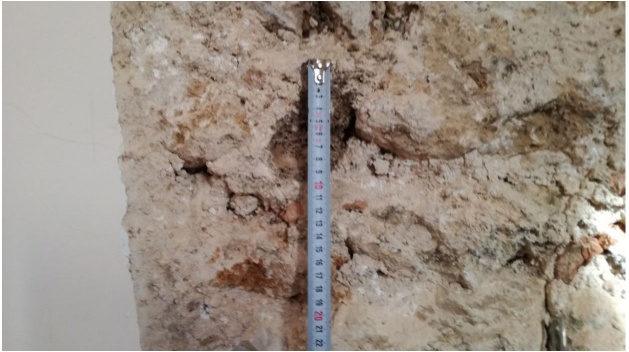
Foto n.17- INDAGINE VISIVA IV 11
