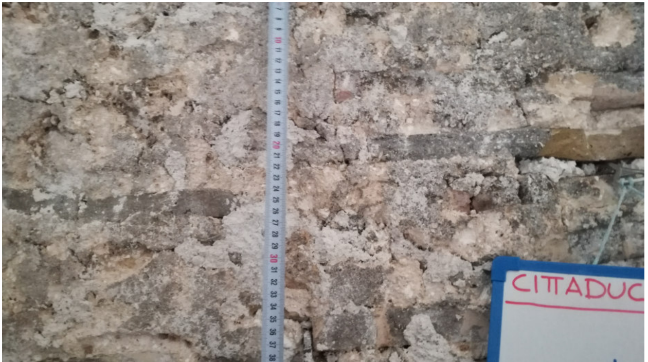
Foto n.2 – INDAGINE VISIVA IV 1
