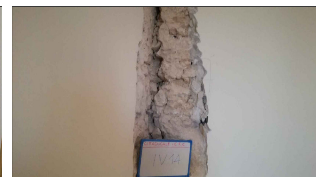
Foto n.21 - INDAGINE VISIVA IV 14
