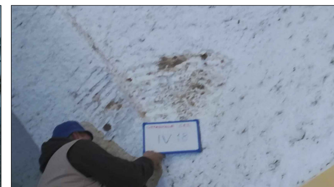
Foto n.28 - INDAGINE VISIVA IV 18
