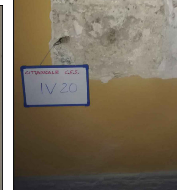
Foto n.31 - INDAGINE VISIVA IV 20
