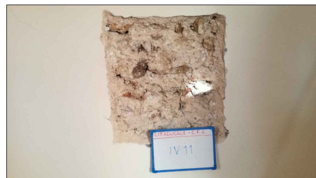
Foto n.16 - INDAGINE VISIVA IV 11
