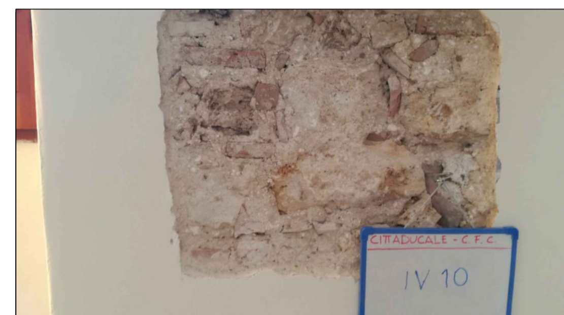
Foto n.14 - INDAGINE VISIVA IV 10
