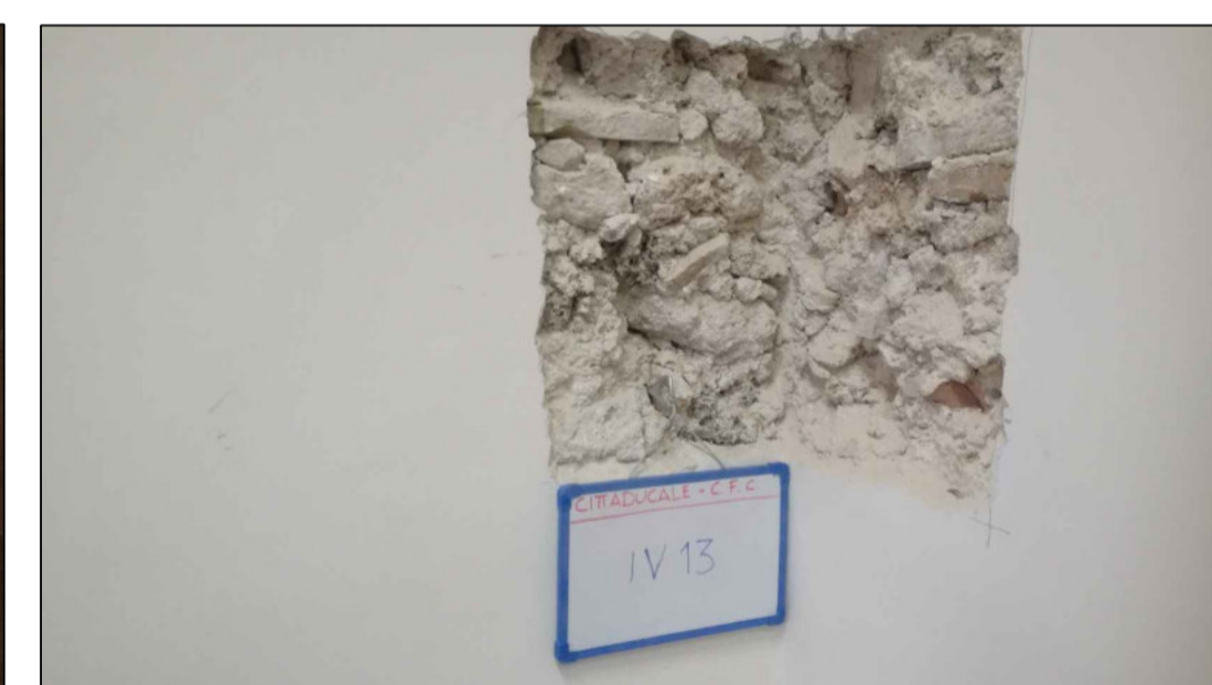
Foto n.20 - INDAGINE VISIVA IV 13
