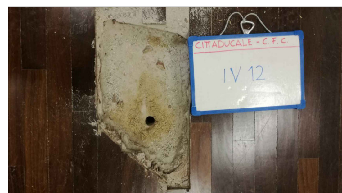
Foto n.18 - INDAGINE VISIVA IV 12
