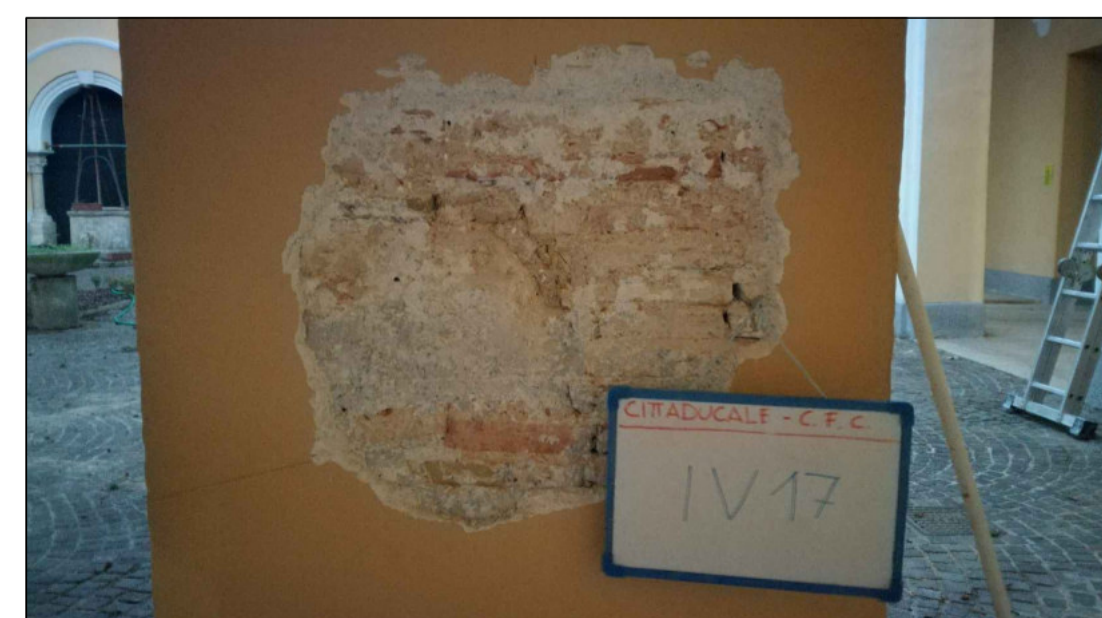
Foto n.27 - INDAGINE VISIVA IV 17
