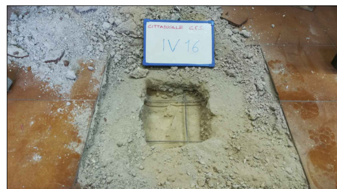
Foto n.25 - INDAGINE VISIVA IV 16
