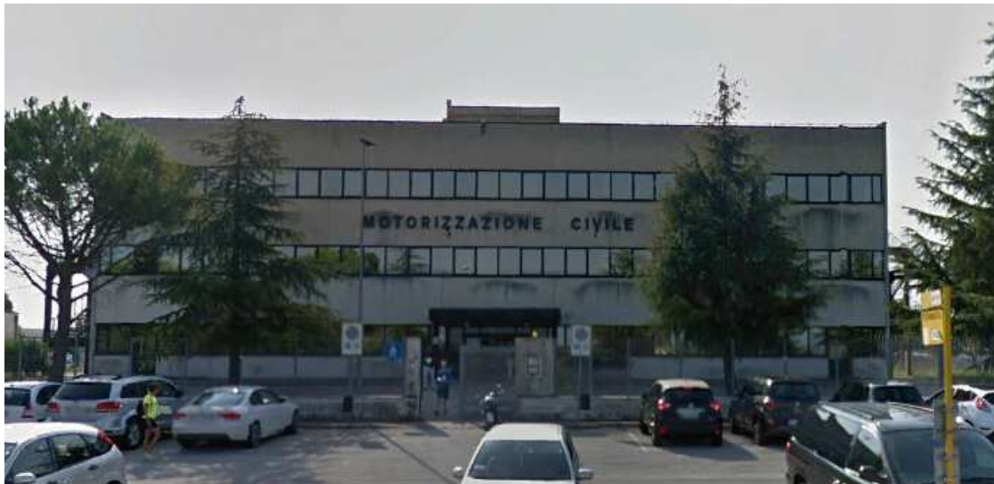
Vista fronte edificio UMC
