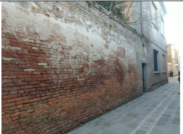
Foto 06- Prospetto su Calle Foscarini
