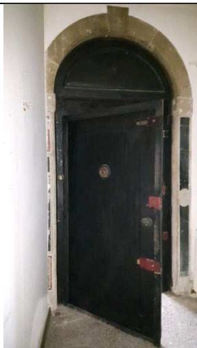
Dettaglio porta con spallette decorate al piano primo ingresso alloggio
