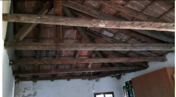
Dettaglio travi di copertura soffitta
