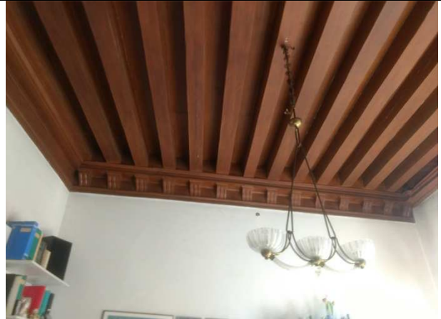
Dettaglio travi appartamento lato giardino piano primo
