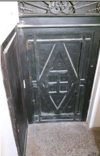
Particolare porta piano primo
