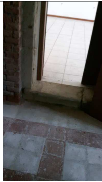
Dettaglio pavimentazione salone ingresso al piano terra
