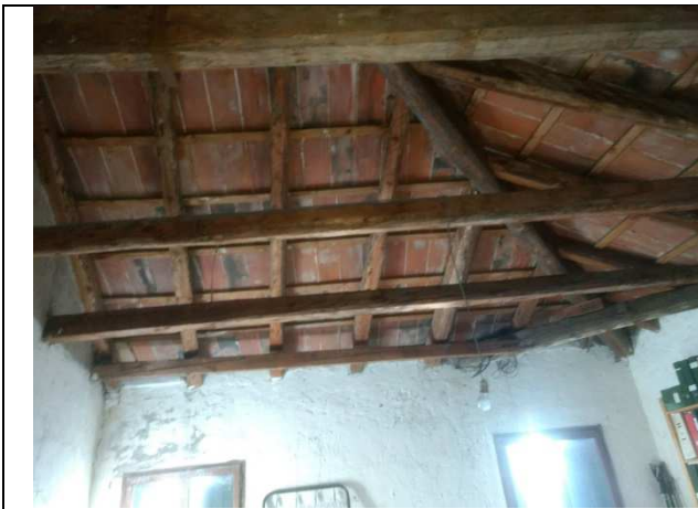
Foto 01- copertura soffitta lato sud-ovest
