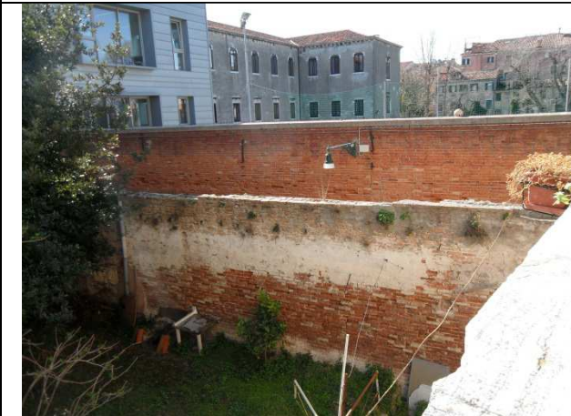
Foto 05- dettaglio muro di cinta su Calle Foscarini
