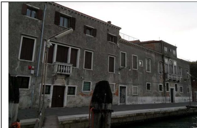
Foto 01- Prospetto Nord/Est Fondamente Nuove
