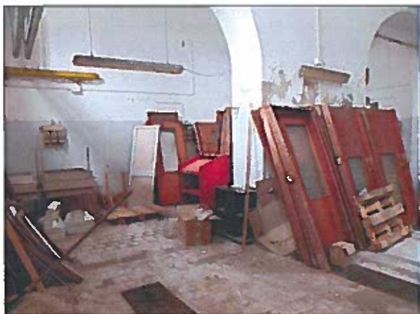
Palazzina Musso - Locali deposito piano terra
