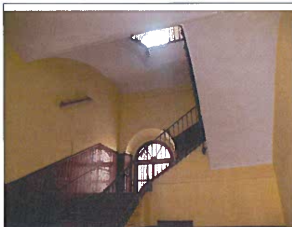
Palazzina Musso - Vano scala
