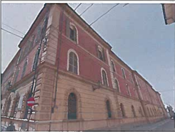
Palazzina Musso - Panoramica est
