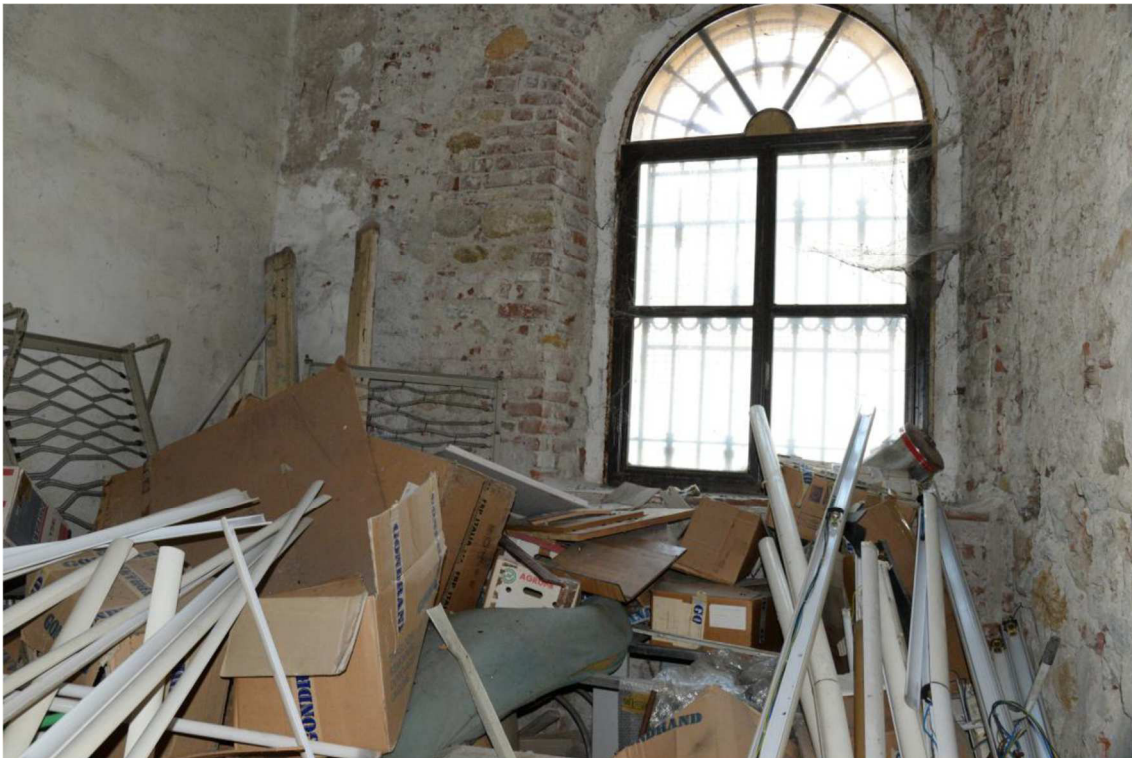
Figura 4 Foto degli ambienti interni
