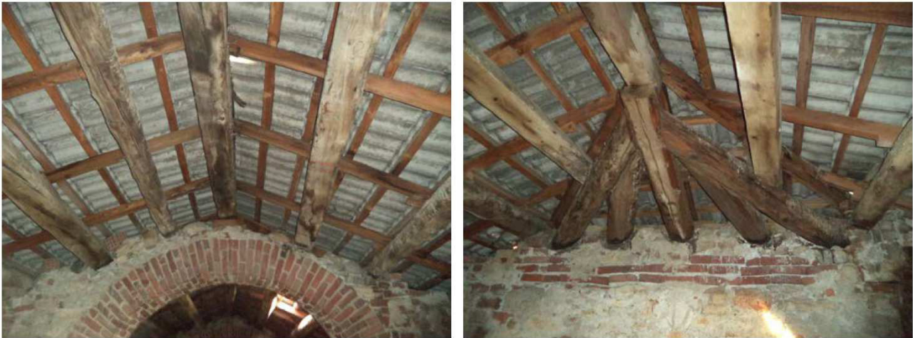
Figura 6 Foto sottotetto e copertura a struttura lignea
