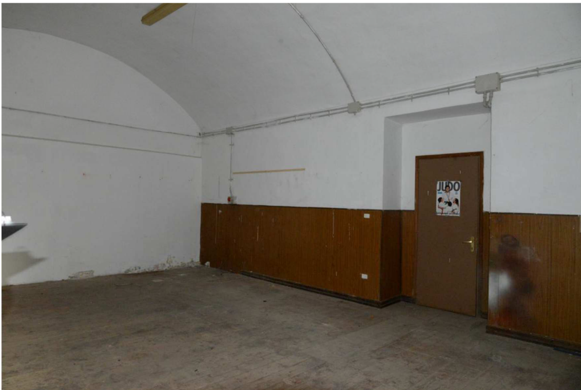
Figura 5 Foto degli ambienti interni
