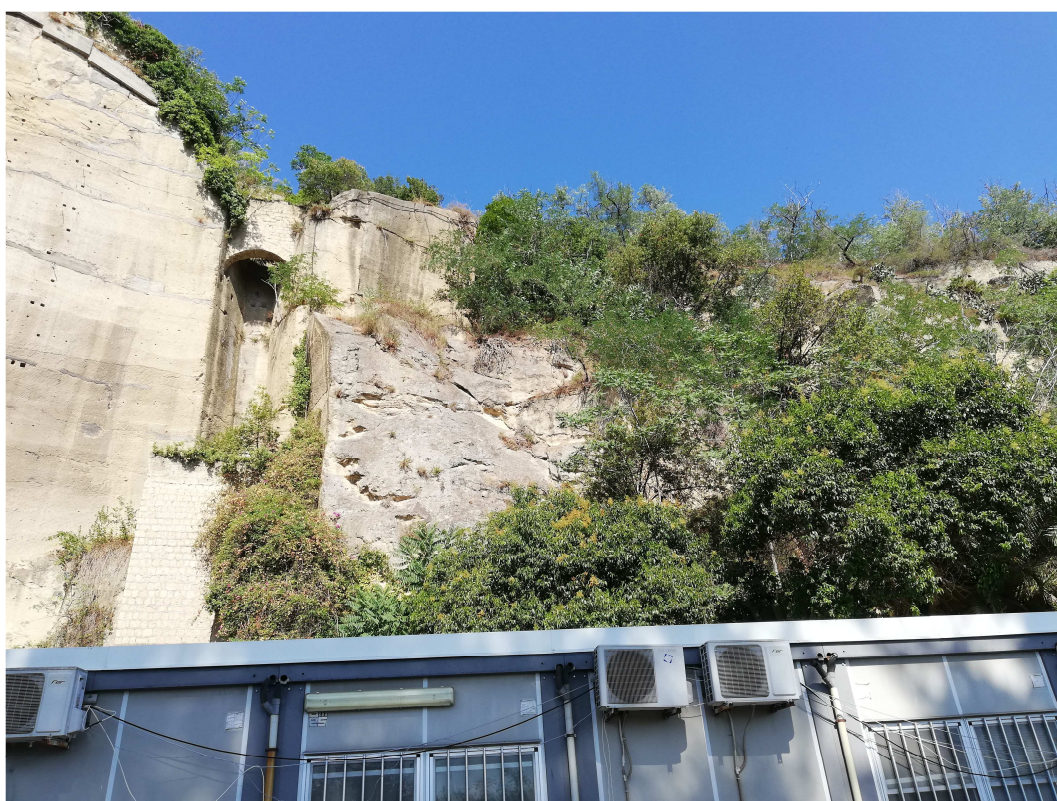
Foto 3 – Parete in tufo non protetta da rete
