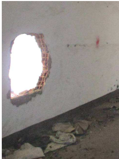
Figura 13 Particolare tramezzature interne al primo piano.
