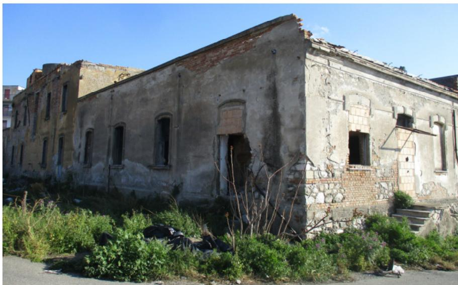
Figura 6 Struttura verticale murature.
