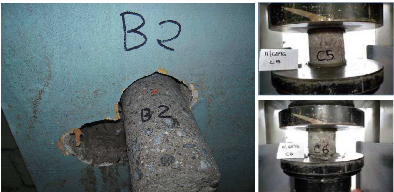
Foto 13 Prelievo carote B2 dal pilastro 2 del Blocco B: sul pilastro sono state prelevate due carote per l'esecuzione di prove di laboratorio (C5 e C6).
