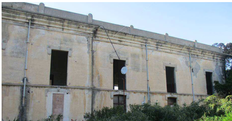
Foto 1 Vista della facciata sud-est del blocco A verso il cortile interno
