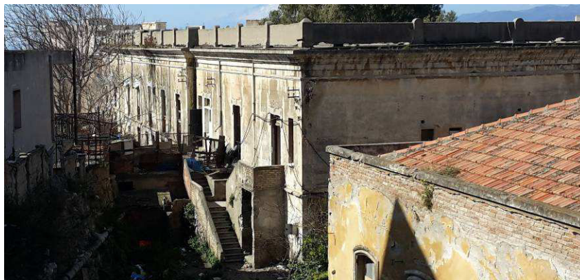
Foto 9 Vista della facciata sud-est del Blocco B.
