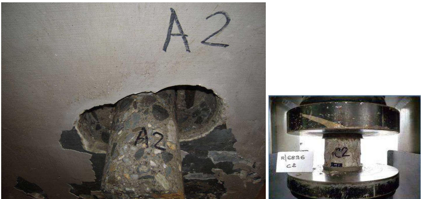
Foto 7 Prelievo carota A2 dal pilastro 2 del Blocco A: sul provino di cls sono state eseguite prove di laboratorio (C2).
