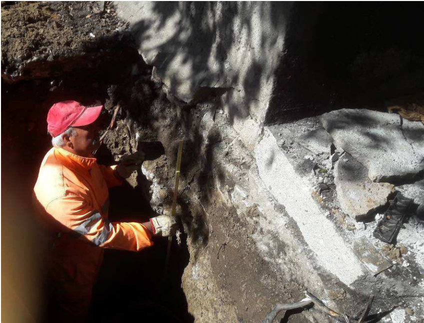
Foto 4 Indagine SF1 (saggio in fondazione) del Blocco A: è stata rilevata una fondazione in cls di altezza pari a 220 cm.
