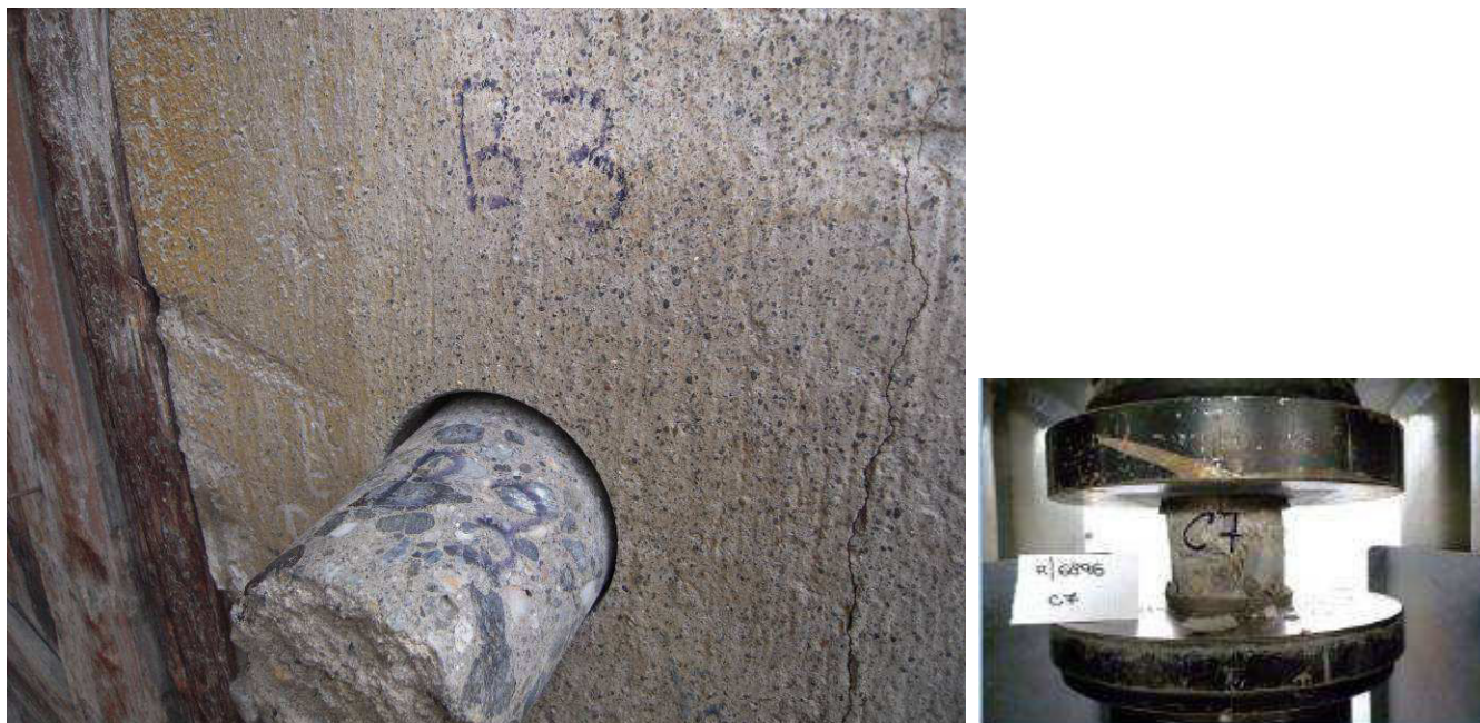
Foto 14 Prelievo carota B3 dal pilastro 1 del Blocco B: sul provino di cls sono state eseguite prove di laboratorio (C7).
