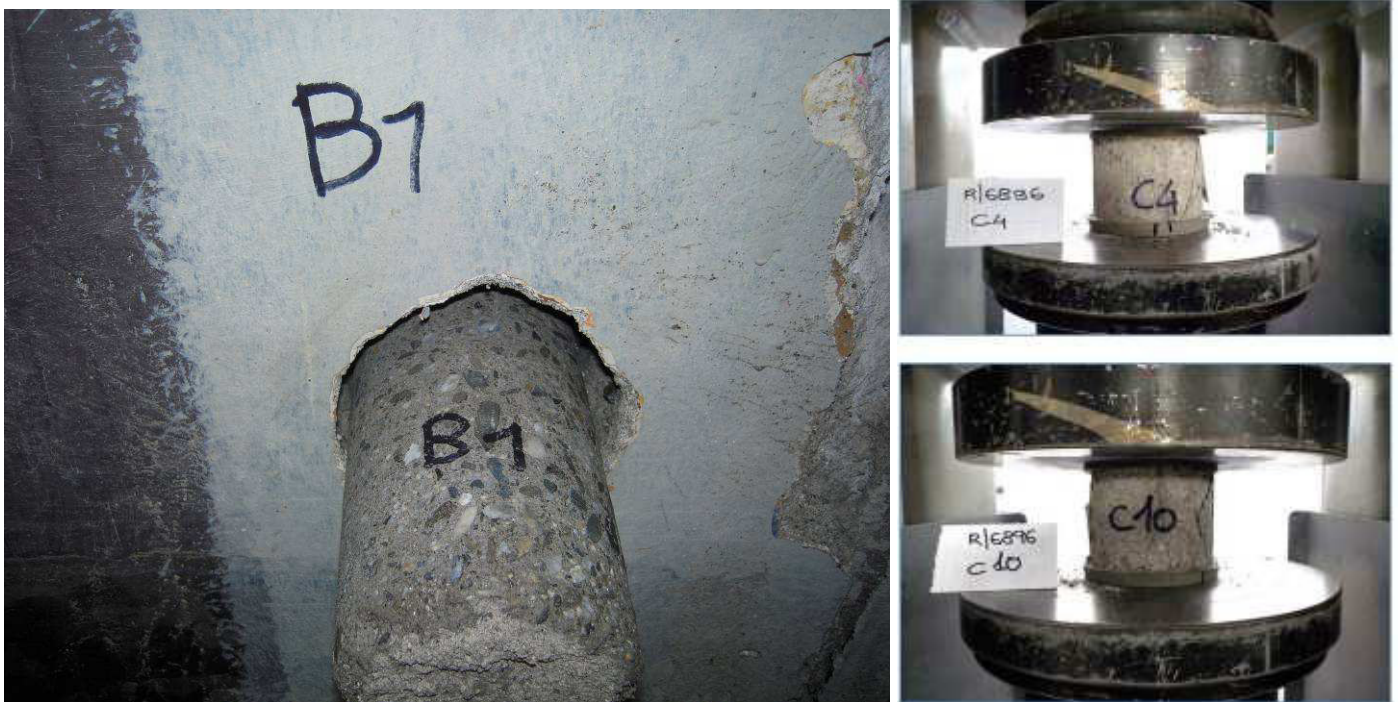
Foto 12 Prelievo carote B1 dal pilastro 3 del Blocco B: sul provino di cls sono state eseguite prove di laboratorio (C4 e C10).
