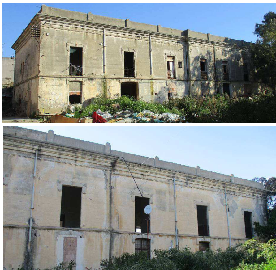
Figura 5 Vista dei prospetti verso il cortile interno delle due “stecche d’artiglieria” (blocchi A e B)
