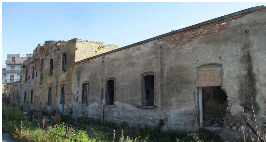
Figura 4 Vista del prospetto sud e nord del corpo centrale detto "Corpo di Comando" (blocco C)
