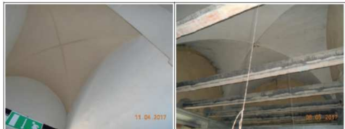
Figura n. 06 - Volta a crociera
