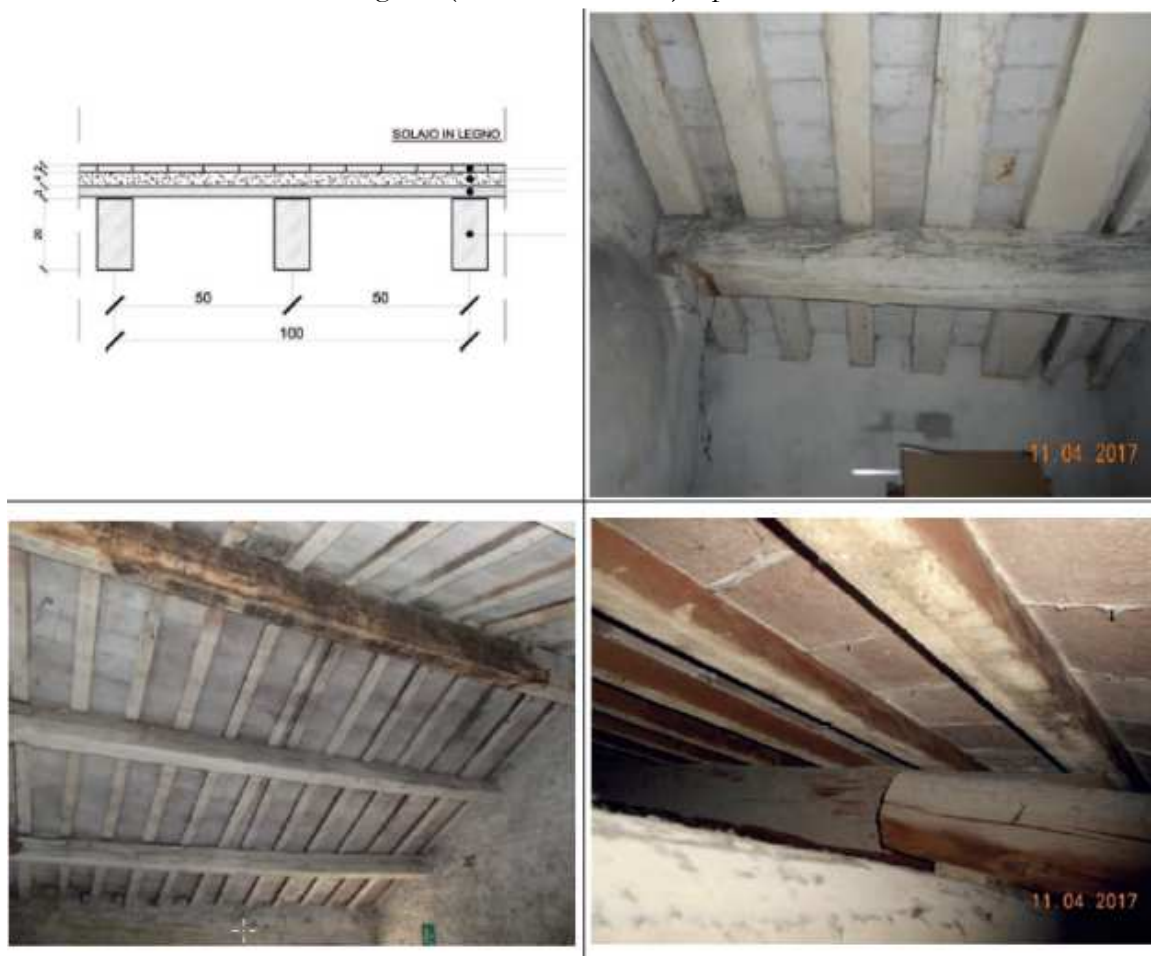
Figura n. 05- Solai in legno
