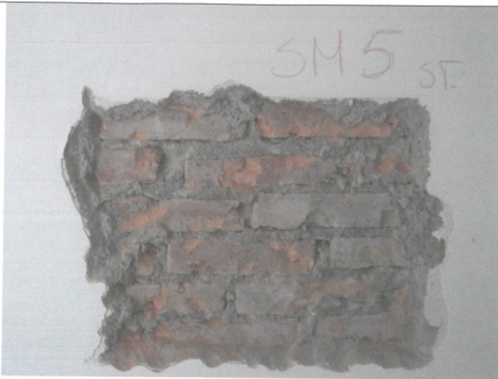
Foto saggio sulla muratura n. 5
