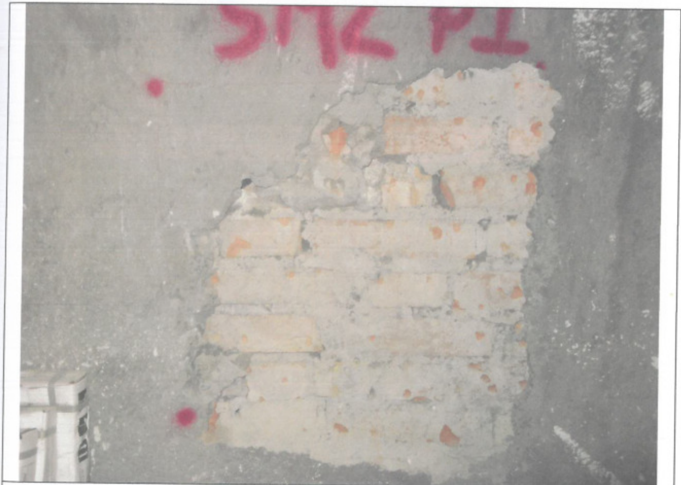
Foto saggio sulla muratura n. 2
