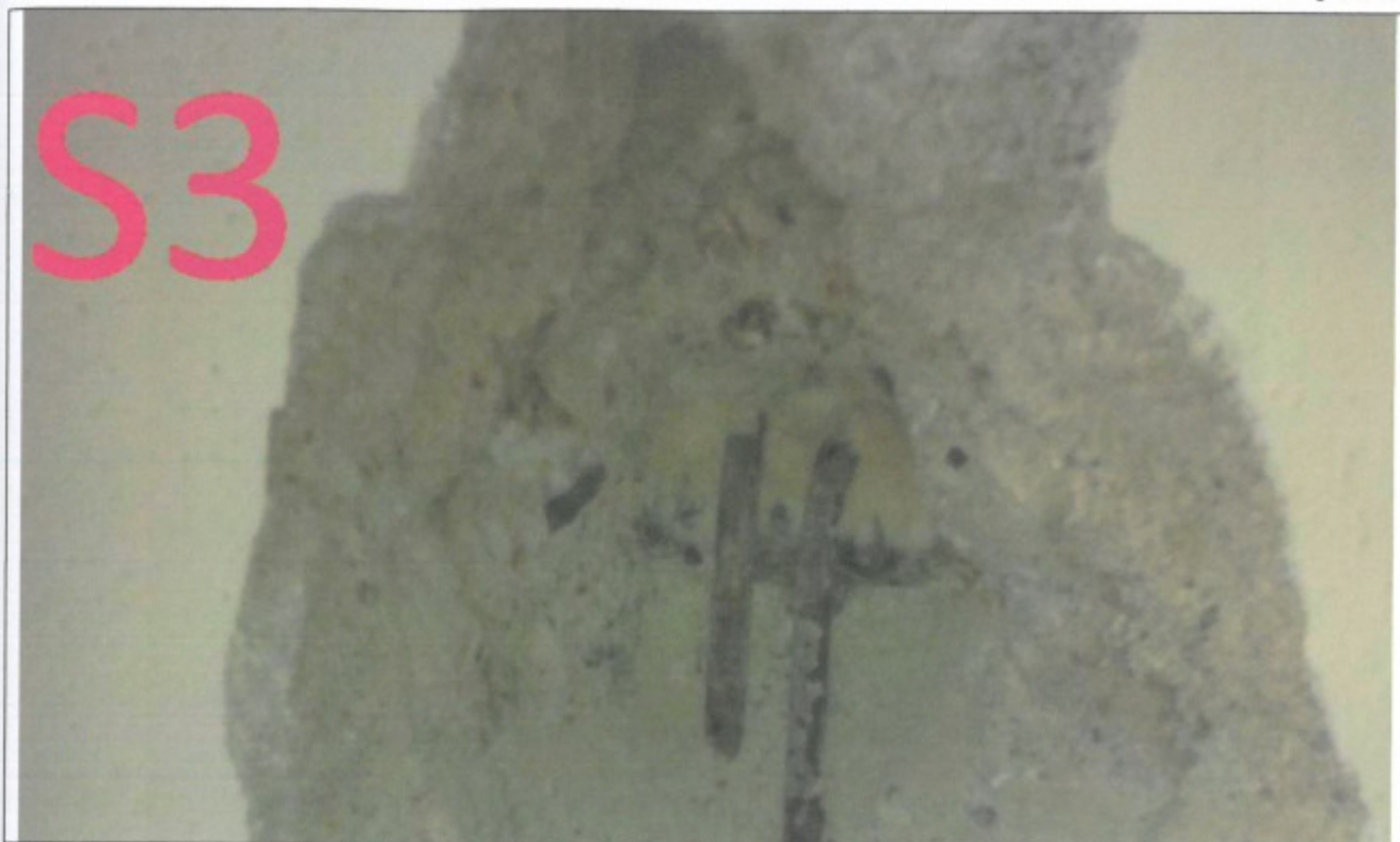
Foto saggio sulle armature n. 3
