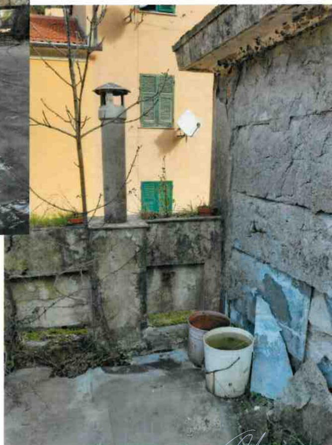
Fig. 9 – Lato Nord della copertura con locale tecnico
