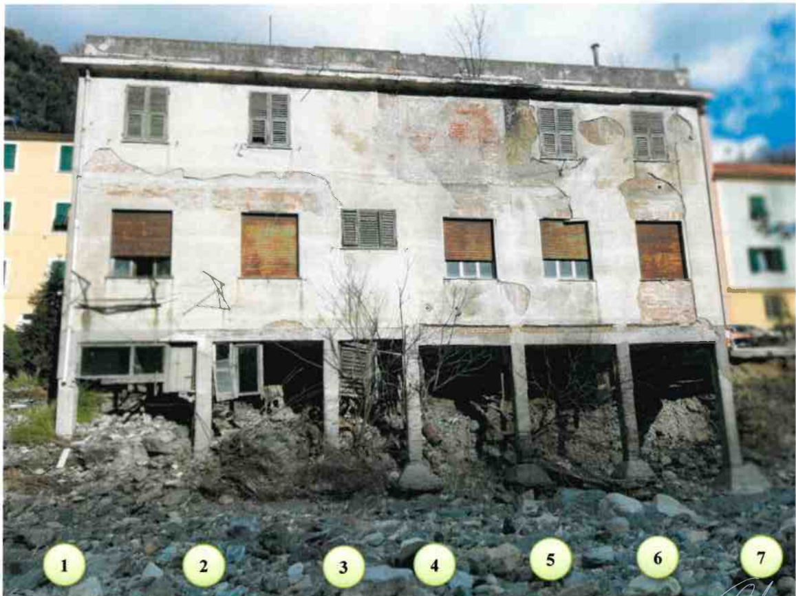
Fig. 5 – Prospetto Sud fabbricato su Torrente Cerusa
