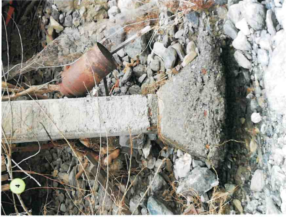
Fig. 16 – Plinto interno all'alveo n° 4 (cfr. fig. 5 e 12)
