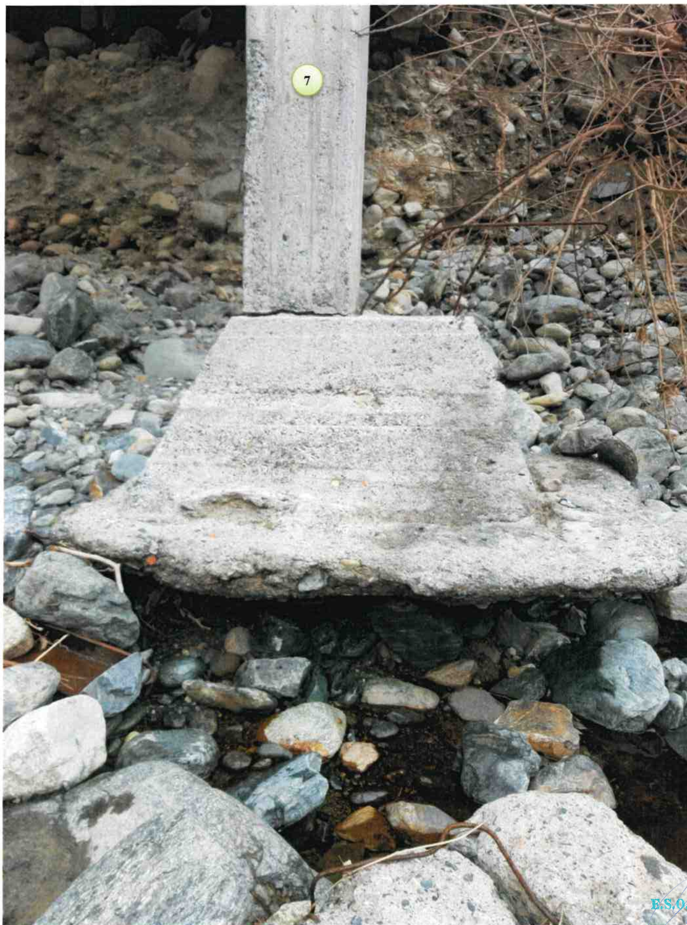
Fig. 19 – Plinto interno all'alveo n° 7 (cfr. fig. 5 e 12)
