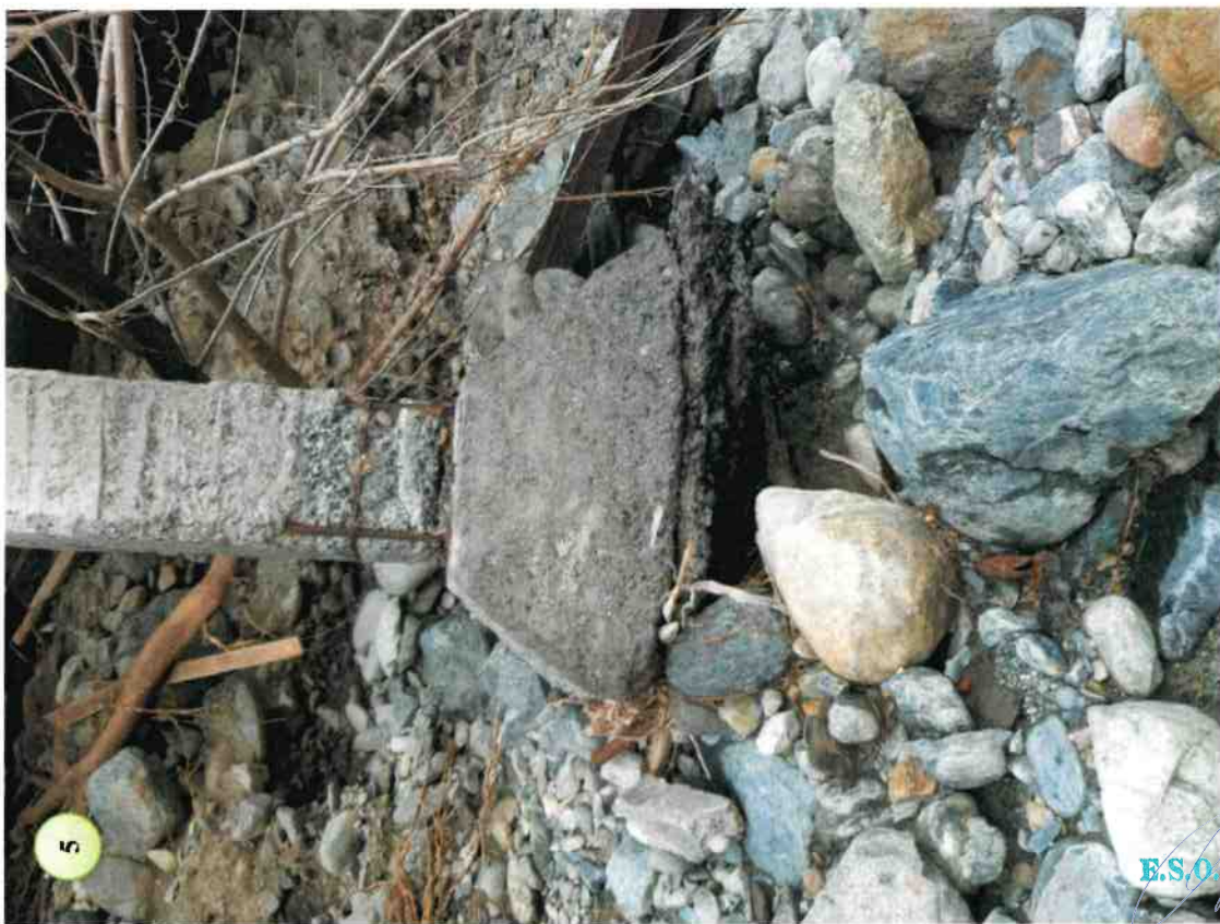
Fig. 17 – Plinto interno all'alveo n° 5 (cfr. fig. 5 e 12)
