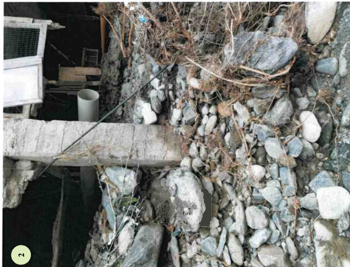
Fig. 14 – Pilastro interno all'alveo n° 2 (cfr. fig. 5)
