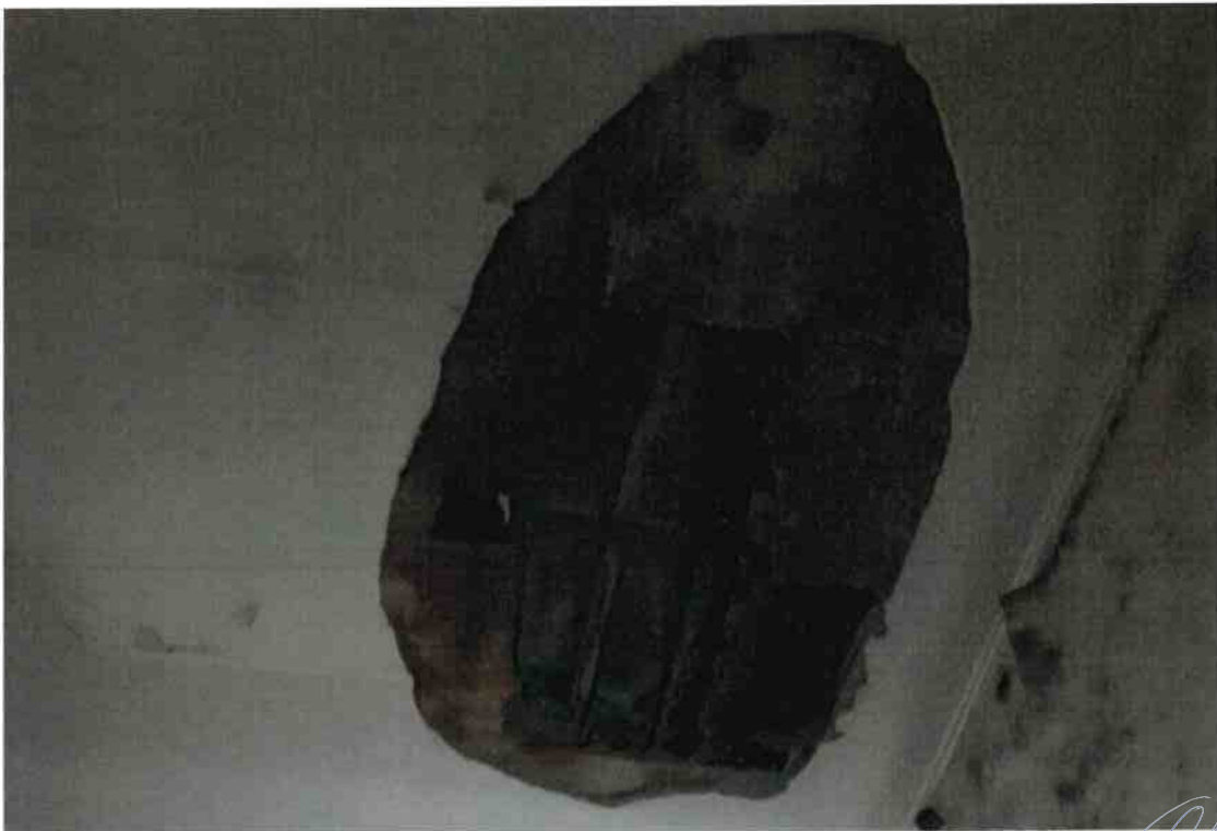
Fig. 25 – Intradosso solaio piano copertura
