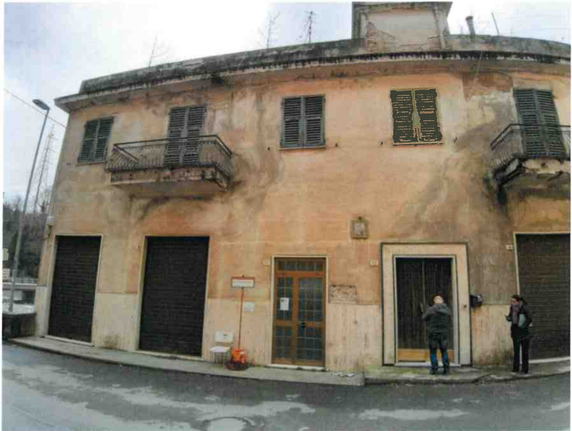
Fig. 4 – Prospetto Nord fabbricato su Via delle Fabbriche
