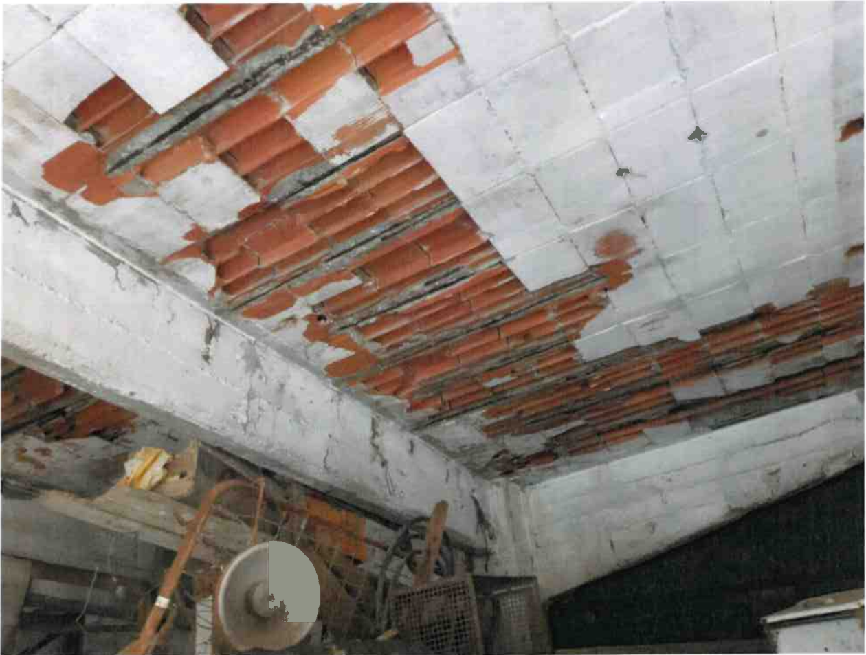
Fig. 24 – Intradosso solaio piano strada tra i pilastri 4 e 5
